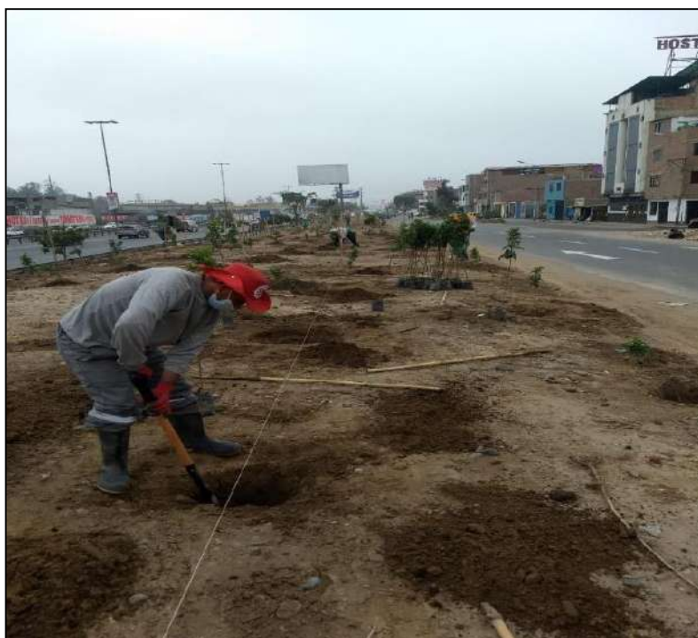
Figura 6: Realización de hoyos en berma lateral de la Panamericana Sur, distrito de San Juan de Miraflores
