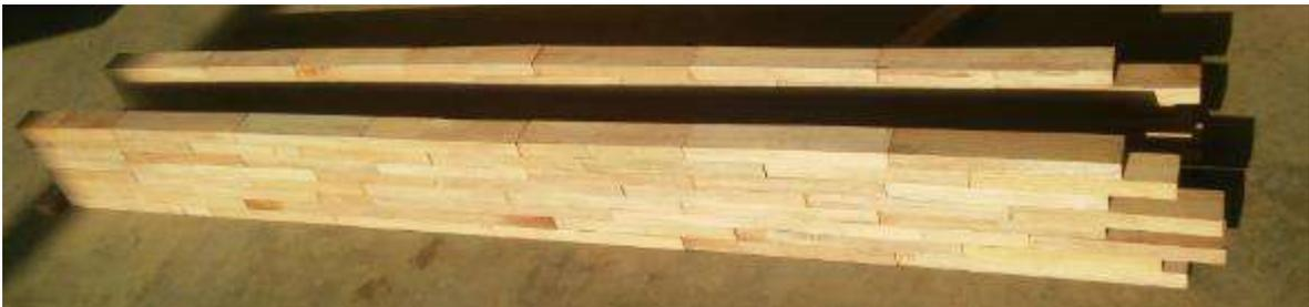
**Figura 13: Pre-armado de vigas laminadas**
