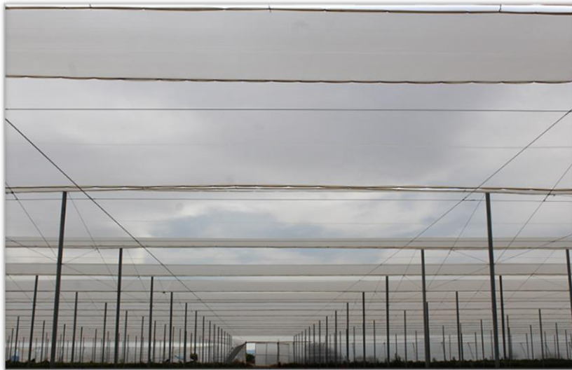
Figura 4. Interior de nave de casa malla
