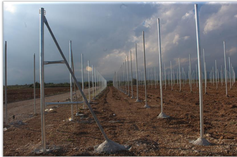
Figura 10. Postes perimetrales y centrales.
