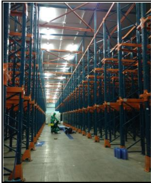
Figura 17: Cámara de congelados
