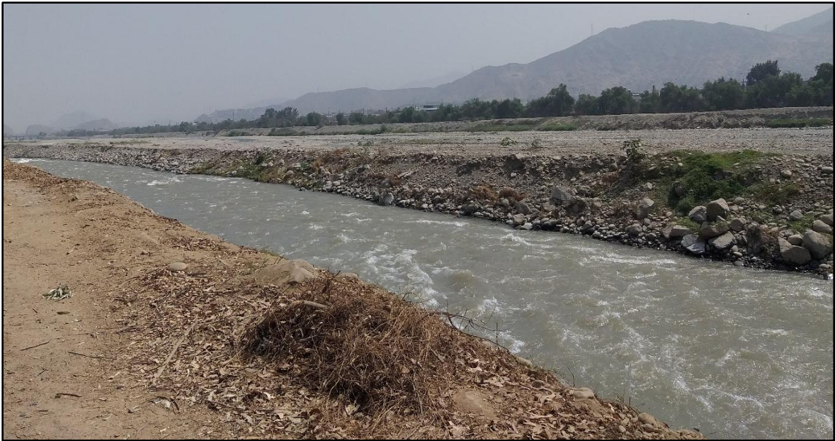
Figura 31: Conformación del material del dique de embancamiento
