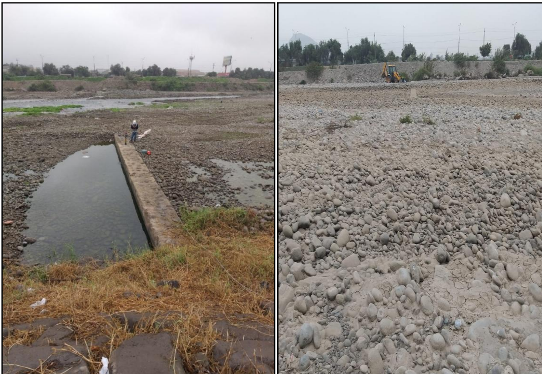
Figura 18: Pantallas de infiltración enterradas parcial y totalmente
