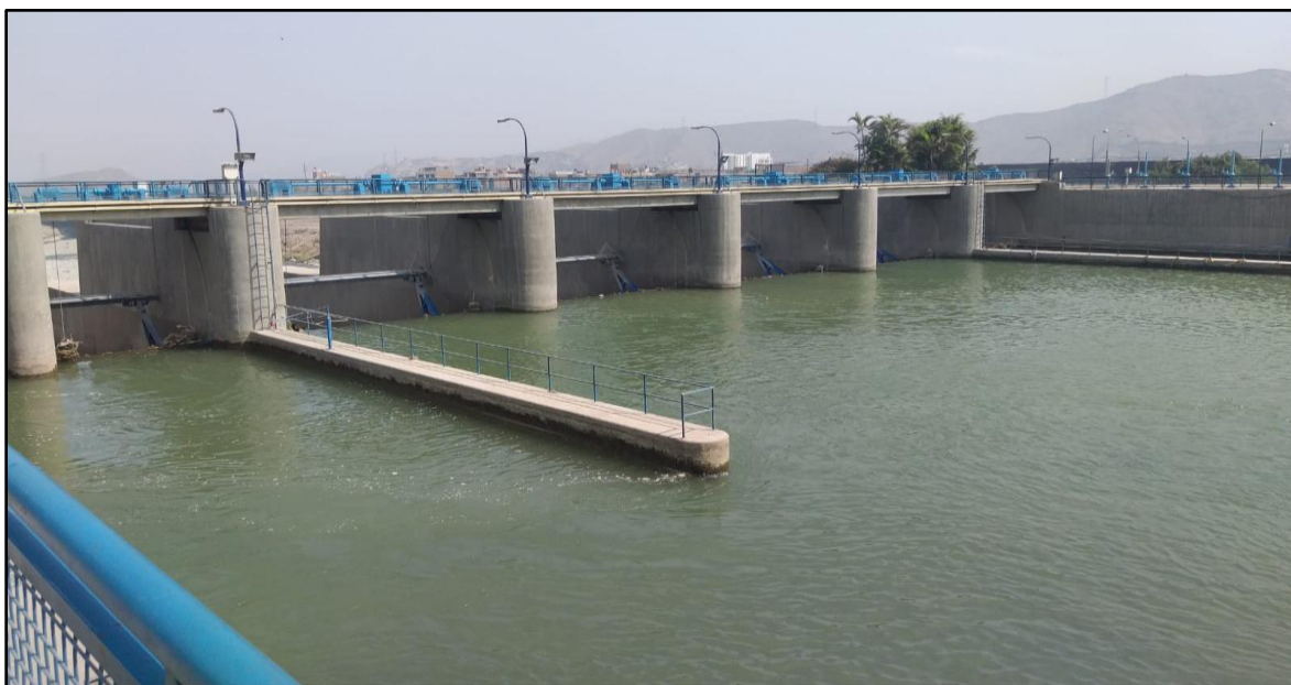
Figura 9: Vista aguas arriba de la bocatoma La Atarjea
