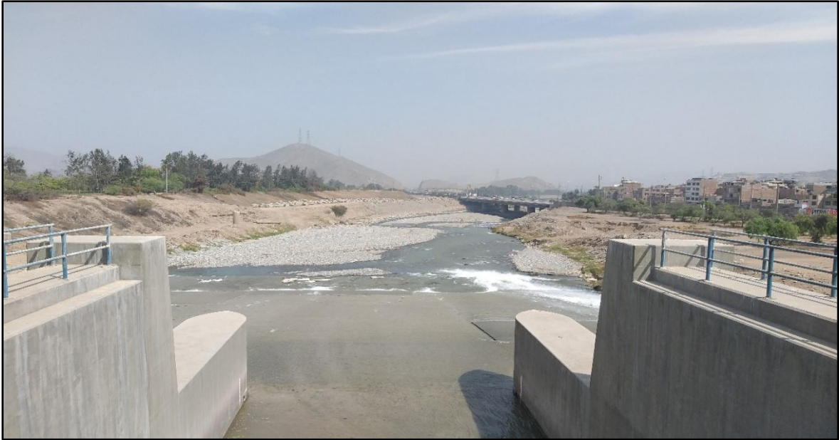
Figura 10: Vista aguas debajo de la bocatoma La Atarjea
