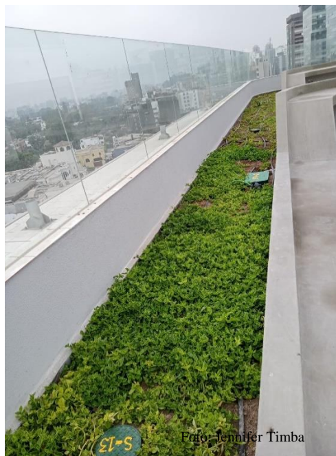
Figura 4. Techo verde extensivo en el distrito de Miraflores.
