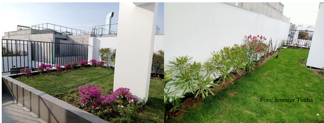
Figura 5. Techo verde intensivo simple en el distrito de Miraflores.
