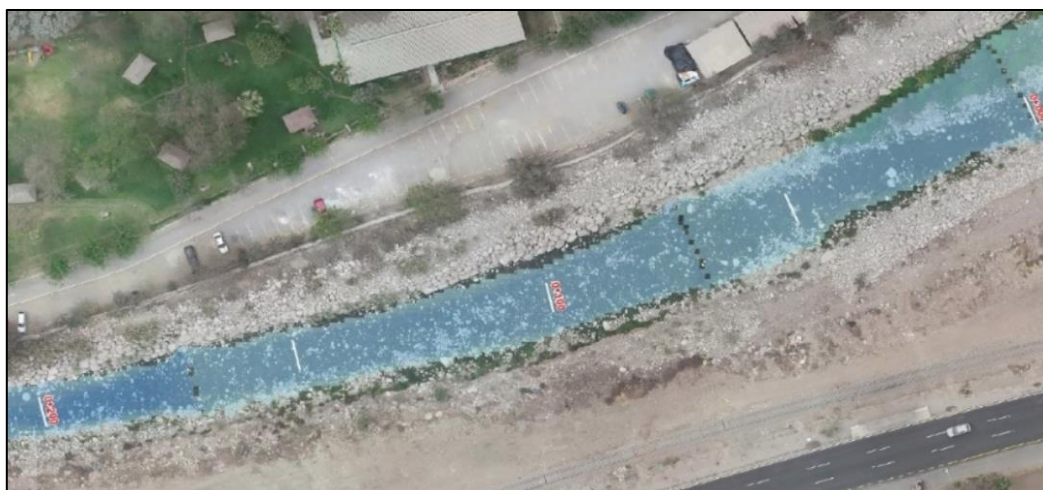
Figura 26. Tramo 0+000 a 0+200 km – Epoca de estiaje con mancha de agua generada
