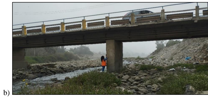
Figura 30. Toma de altura de marca de agua en el puente Morón a) y b)
