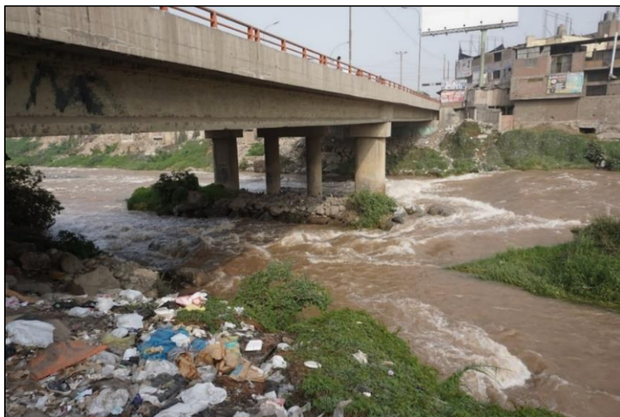
Figura 31. Puente Huachipa ubicado en el km 15+470
