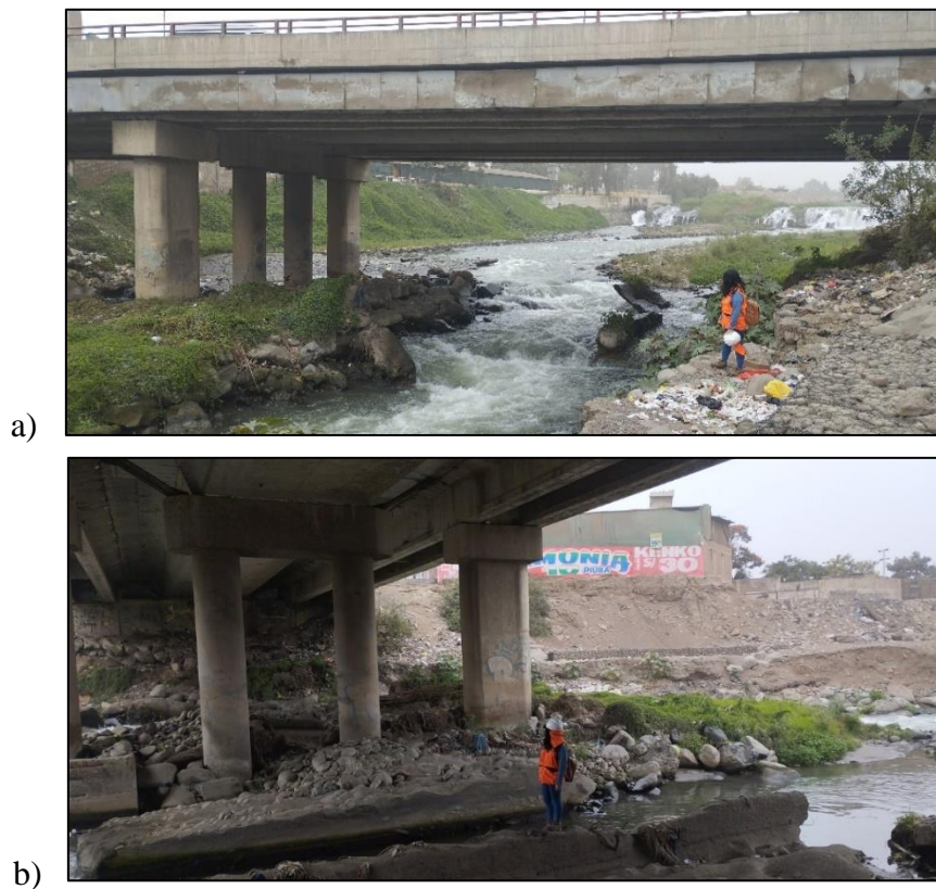
Figura 32. Toma de altura de marca de agua en el puente Huachipa
