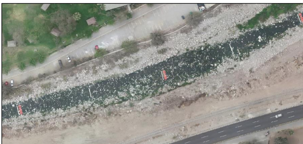
Figura 25. Tramo 0+000 a 0+200 km – Epoca de estiaje (2020)
