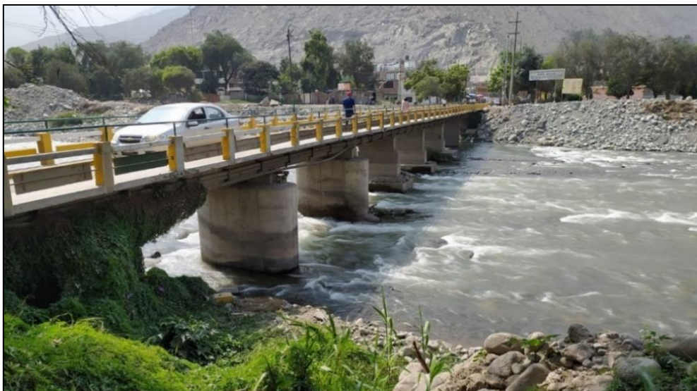
Figura 29. Puente Morón ubicado en el km 1+734
