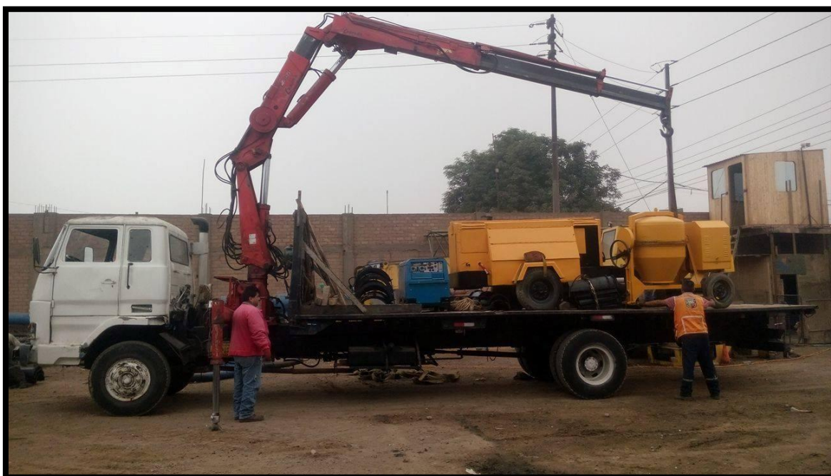
Figura 26: Movilización de mezcladora desde almacene del proveedor
