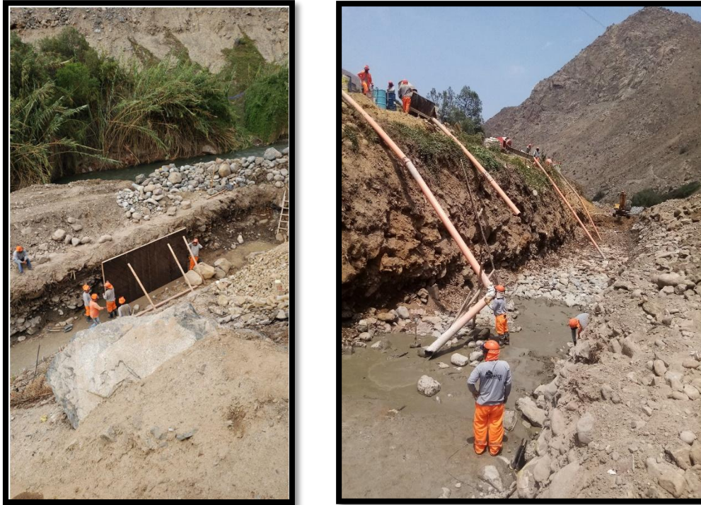
Figura 38: Encofrado de cimientos, progresiva 0+050.0
