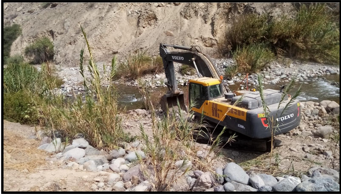
Figura 35: Desvío del río con maquinaria
