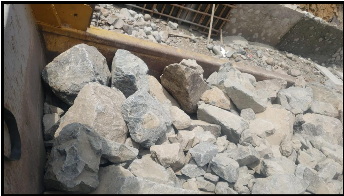
Figura 37: Traslado de piedra seleccionada al punto de acopio
