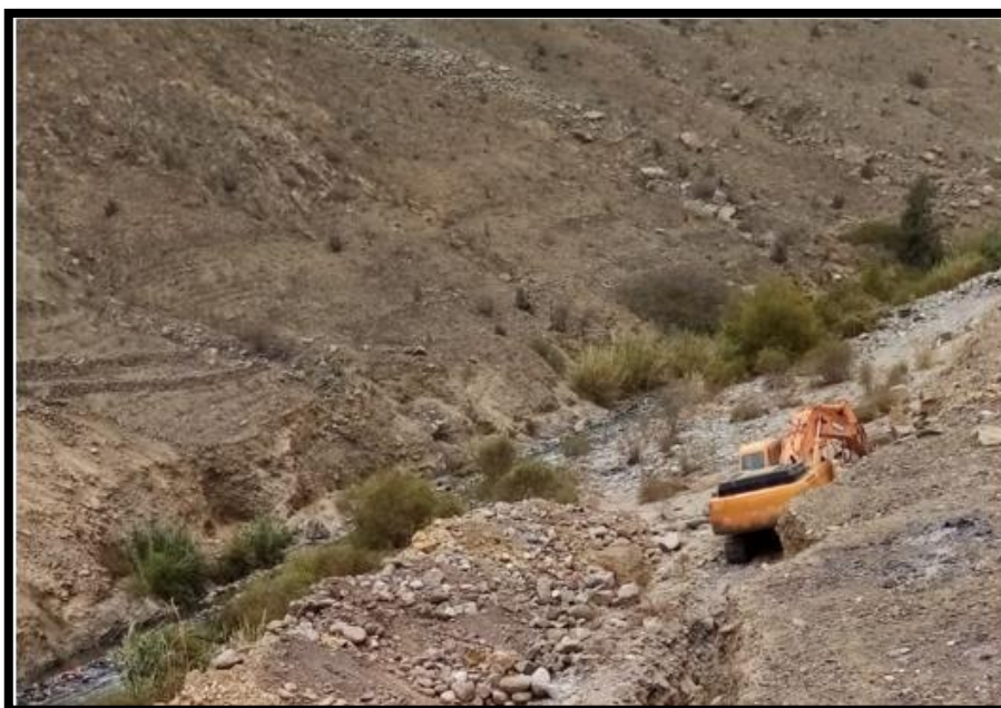
Figura 25: Limpieza de terreno sobre la progresiva 0+800.0
