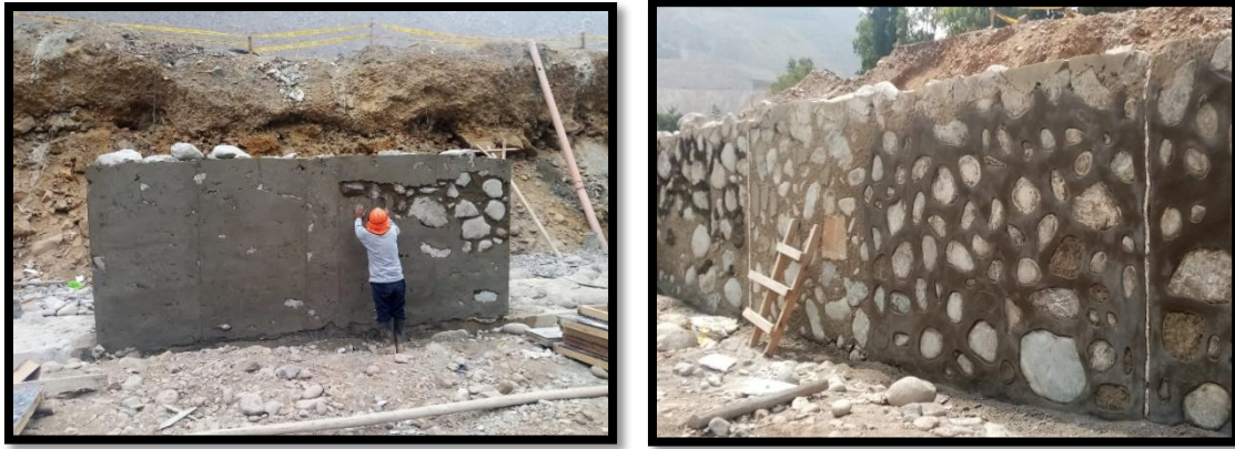
Figura 42: Emboquillado de muro, cuadrilla especializada en esta labor
