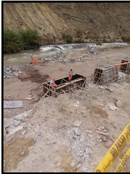
Figura 39: Proceso de encofrado en muro de mampostería
