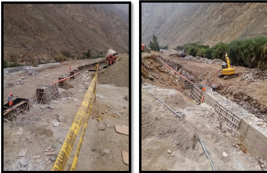
Figura 41: Partida 02.04.03, asentado de muro, señalética de seguridad
