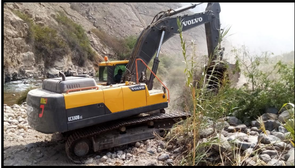
Figura 32: Desbroce y limpieza con retroexcavadora Volvo EC480D
