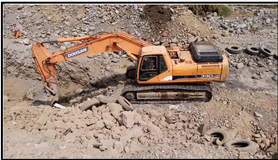
Figura 36: Excavación de estructura en seco
