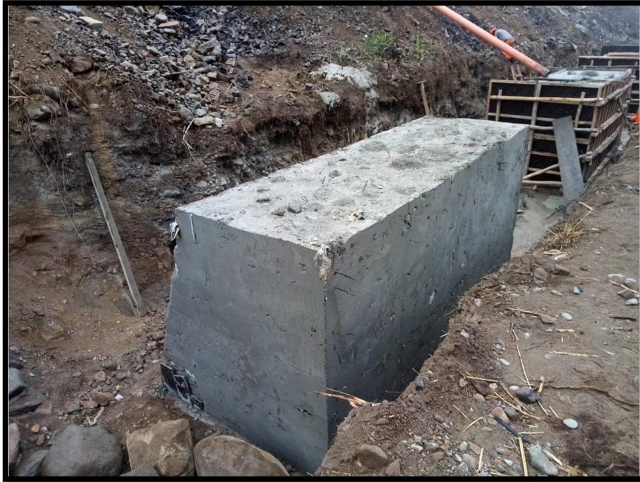
Figura 40: Vista después del desencofrado de pantalla de muro
