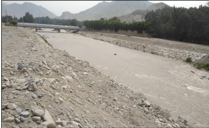
Figura N° 11: Fotografía tomada en temporada de avenidas - progresiva 0+280
