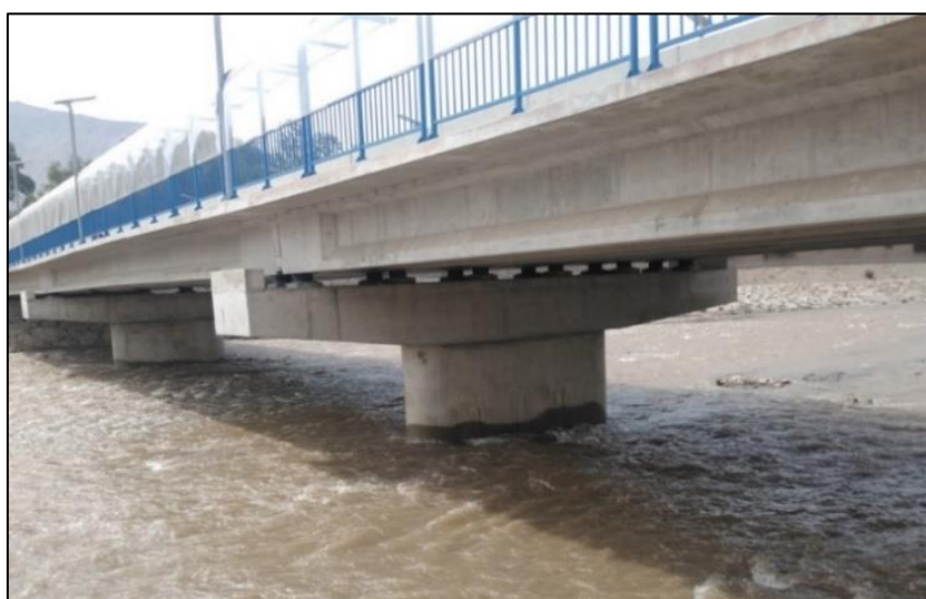
Figura N° 10: Fotografía tomada en temporada de avenidas - progresiva 0+055
