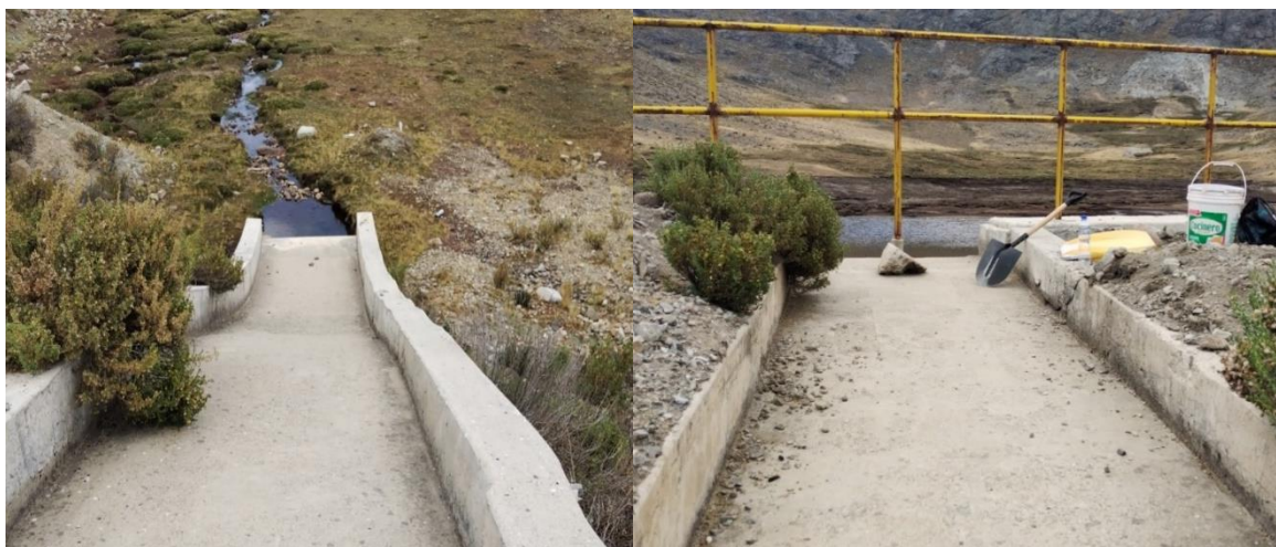
Figura 14: Vista del aliviadero existente en dique
