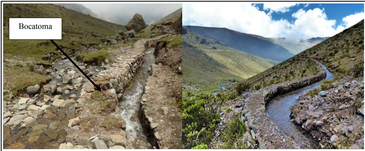
Figura 16: Bocatoma del canal amunero en la progresiva 0+000 km y estructura
