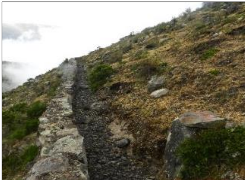
Figura 17: Vista de la progresiva 1+200 km del canal amunero
