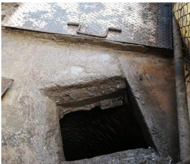
**Figura 11.** Pozo de percolación en deterioro, sobre el que convergen los residuos líquidos, del lavado de pisos, lavaderos y duchas
