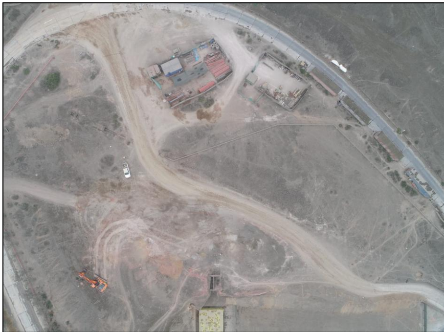
Figura 13: Proyecto antes de la ejecución
