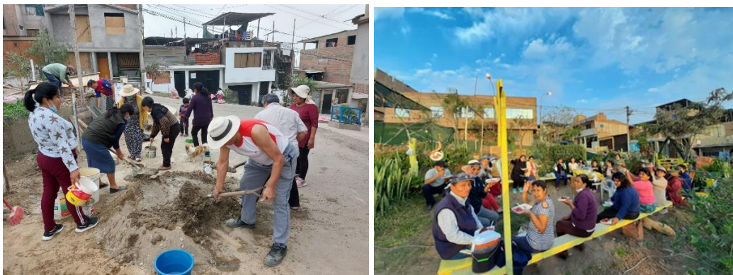
Figura 27: Trabajo comunitario del huerto Ayni, construcción del muro de contención, compartir después de una jornada de trabajo
