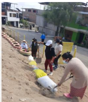
Muros de soporte.
