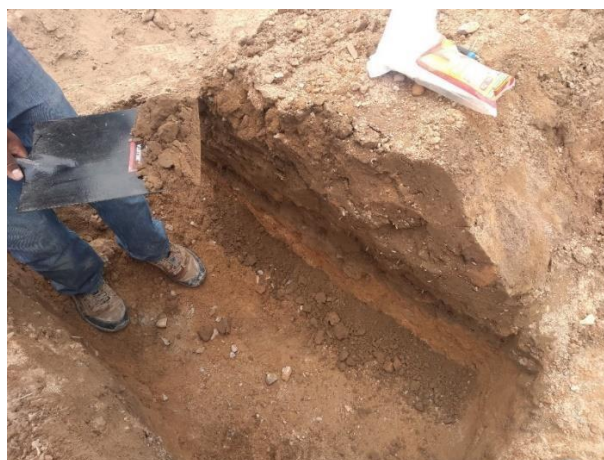
Figura 27: Extracción de muestras de suelo mediante calicatas
