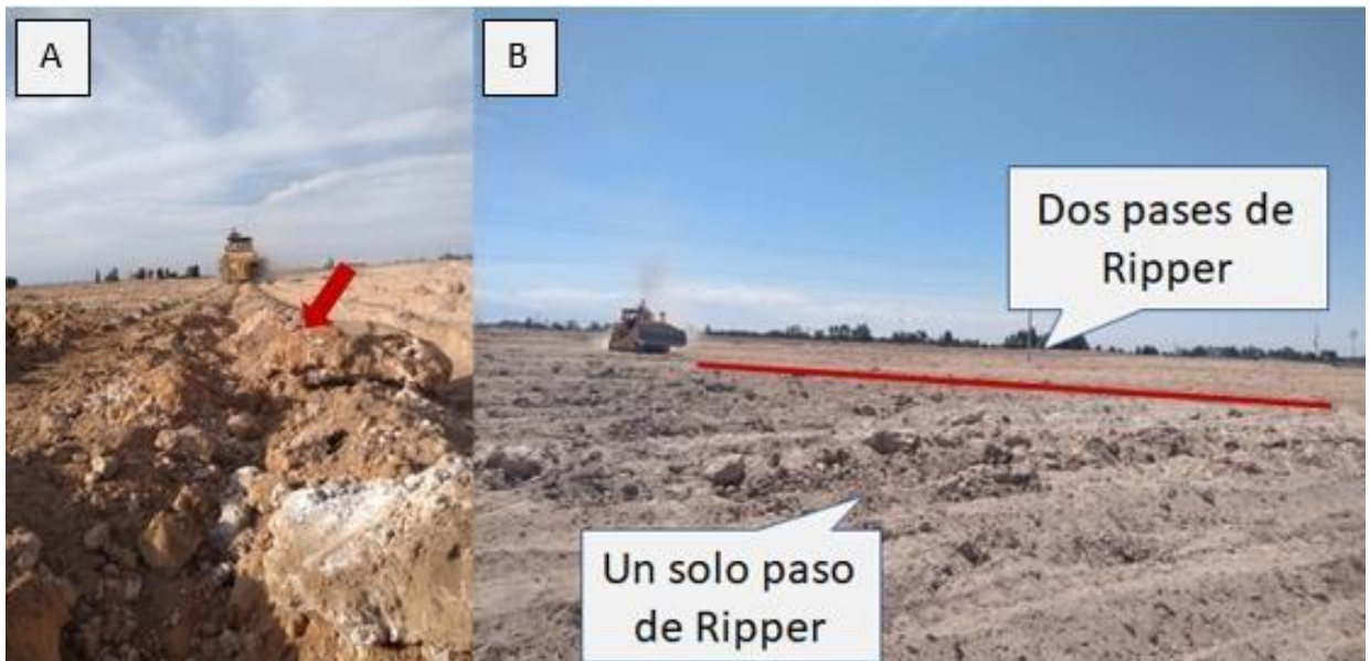
Figura 5: Diferencia entre un pase simple y doble del subsolador (bulldozer D8)
