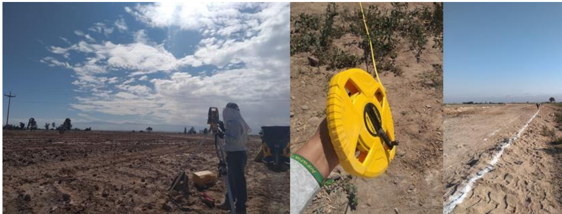
Figura 15: Replanteo topográfico, delimitación y marcado de líneas de siembra
