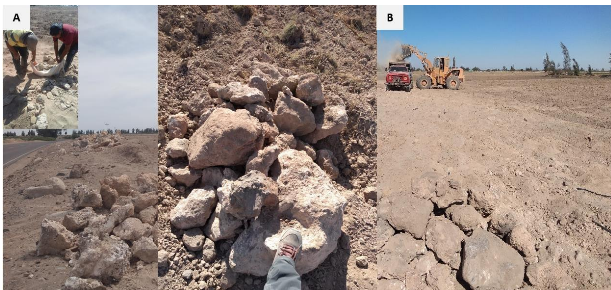
Figura 7: Extracción y carguío de bloques de caliche y piedras
