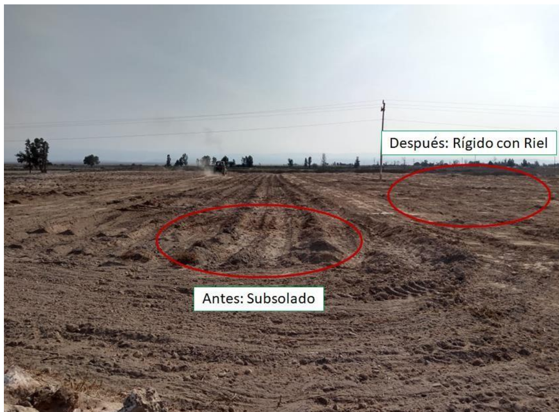
Figura 9: Comparación visual del terreno antes y después del ingreso de rígido
