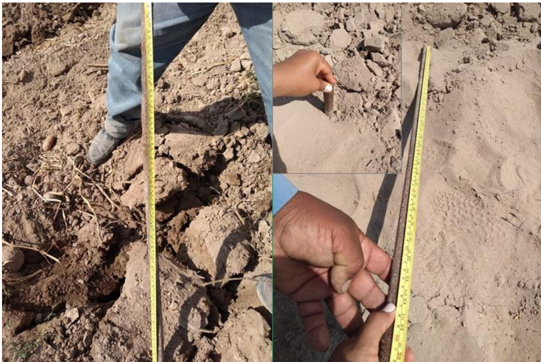
Figura 6: Verificación de profundidad ejecutada por el ripper del bulldozer D8
