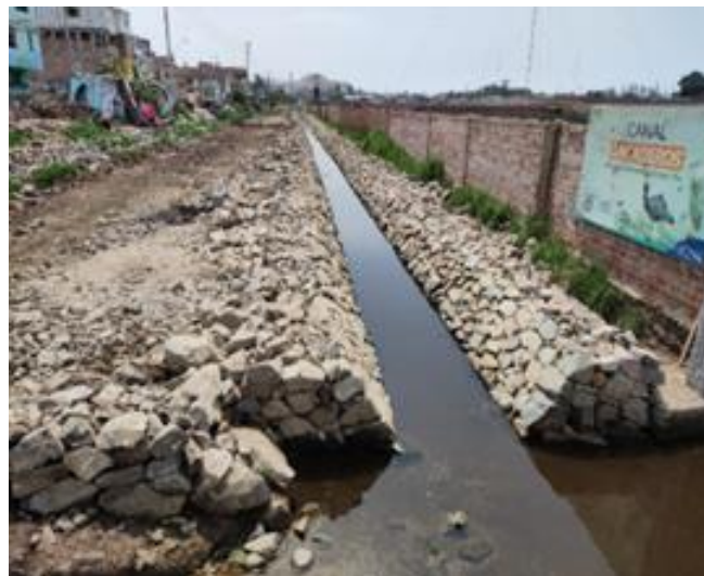
Figura 29. Ejecución de trabajos para no permitir el uso recreativo del agua
