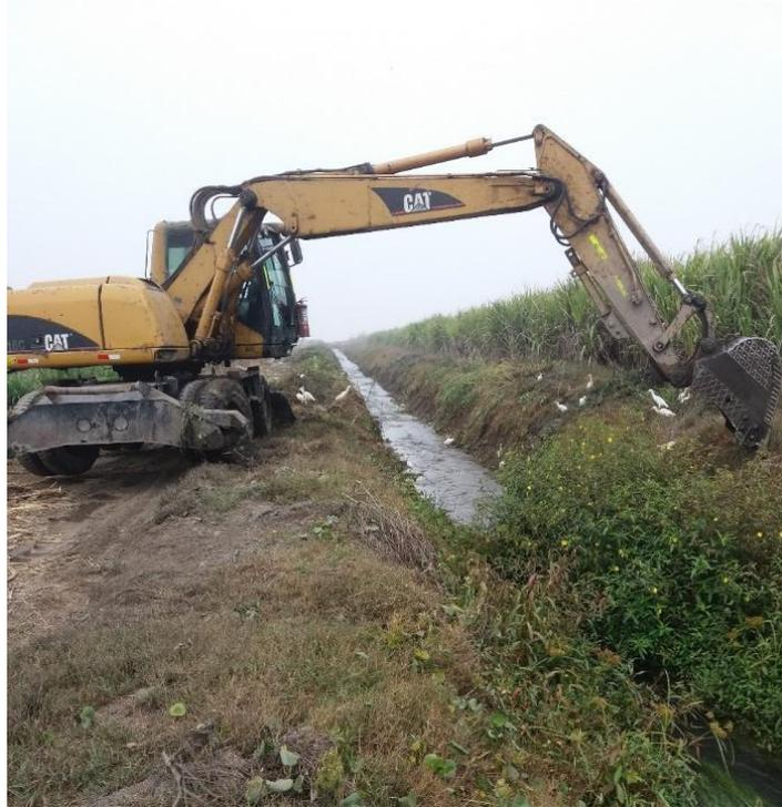
**Figura 47: Limpieza de dren abierto con excavadora**
