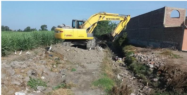
**Figura 46: Champería realizada con excavadora de oruga**
