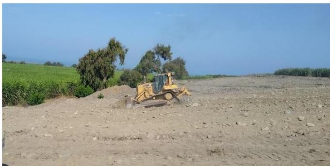
**Figura 10: Nivelación de campo con tractor oruga**
