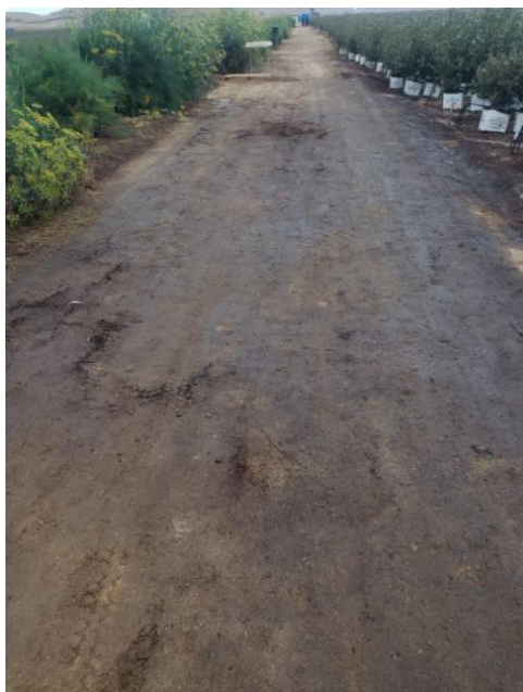
Figura 18: Estabilización de caminos con riegos de agua y salmuera
