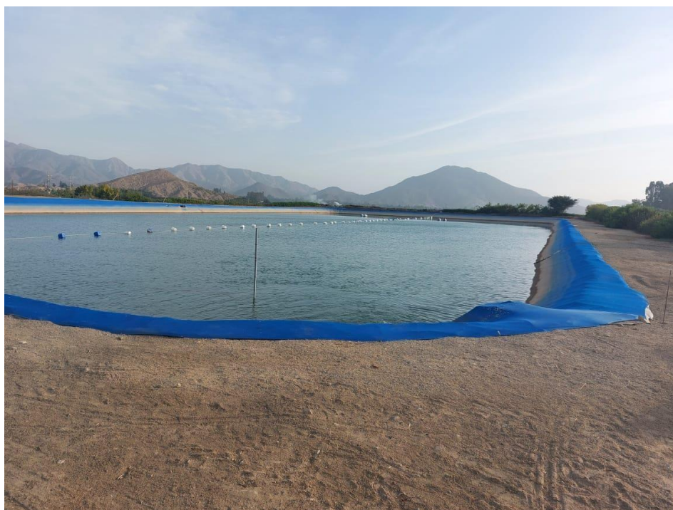
Figura 22: Reservorio de agua
