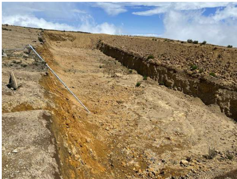
Figura 45. Soporte instalado en qocha
