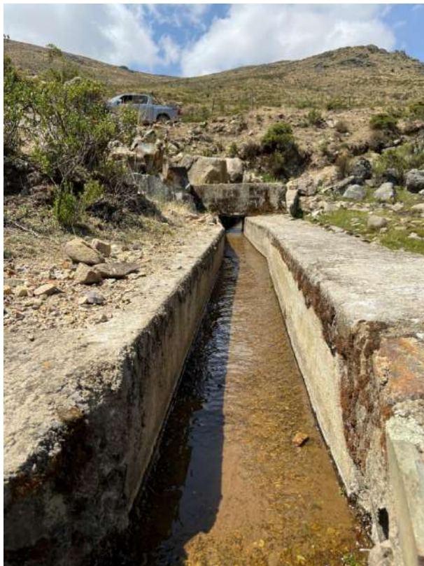
Figura 25. Tramo de concreto
