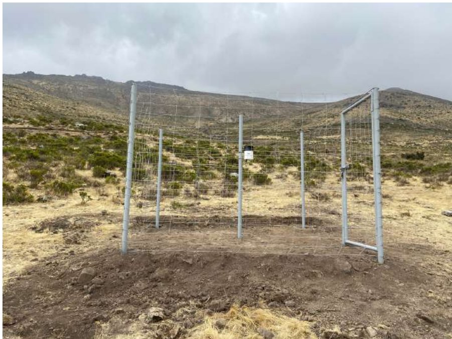
Figura 56. Pluviómetro SAT_PO_04 instalado
