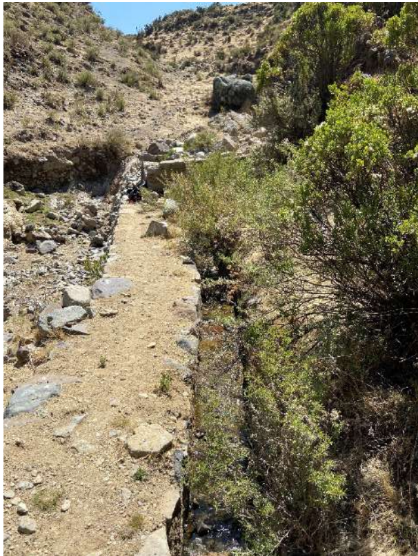
Figura 30. Sección revestida de concreto
