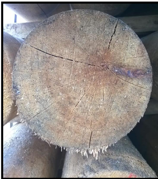
Figura 9. Grietas en la punta de poste de bolaina, producto del secado rápido en esta sección de la pieza de madera. Empresa Maquiwood S.A.C.
