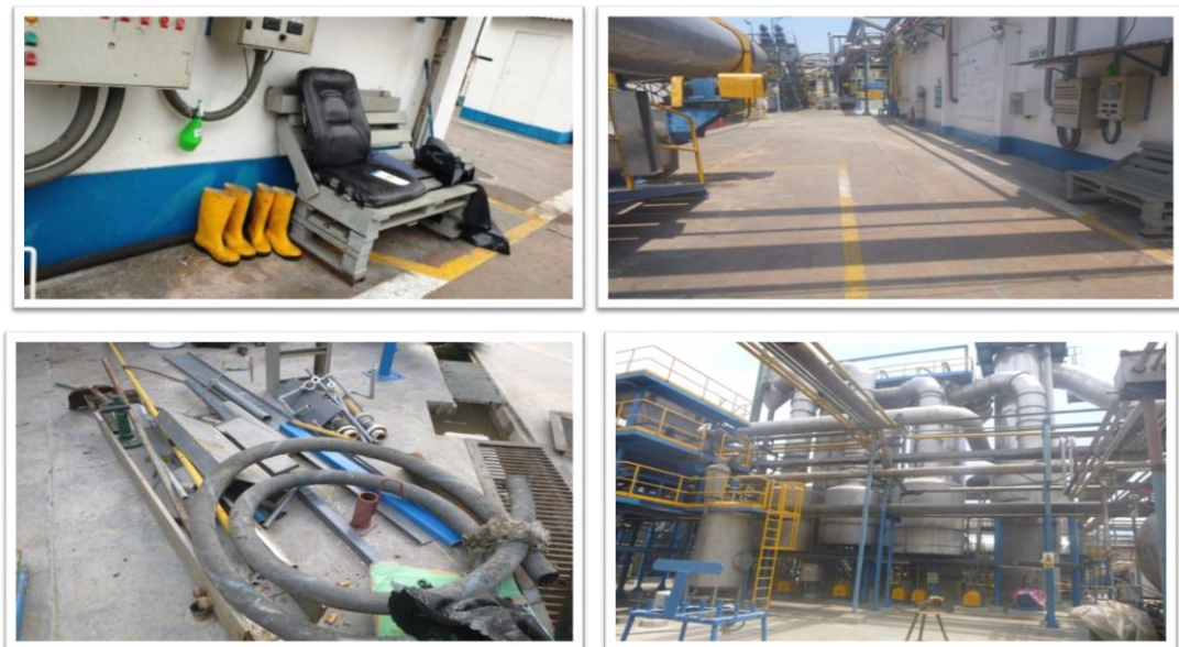
Figura 14. Antes y después de la implementación de las 5S en la planta de producción
