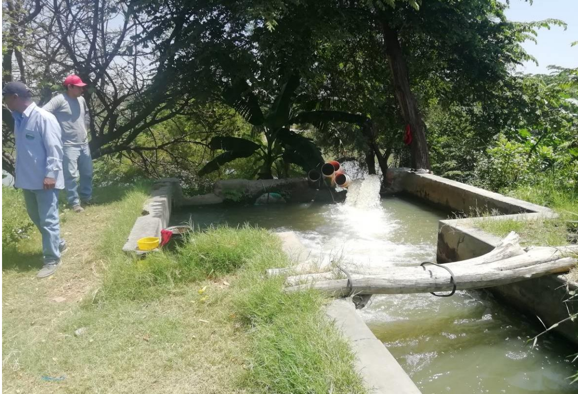
Figura 10. Vista de la cámara de carga
