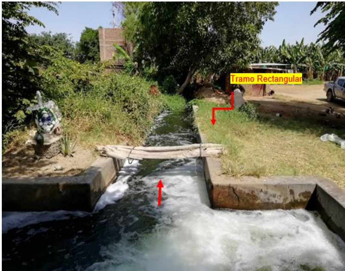
Figura 12. Tramo de canal revestido de sección rectangular
