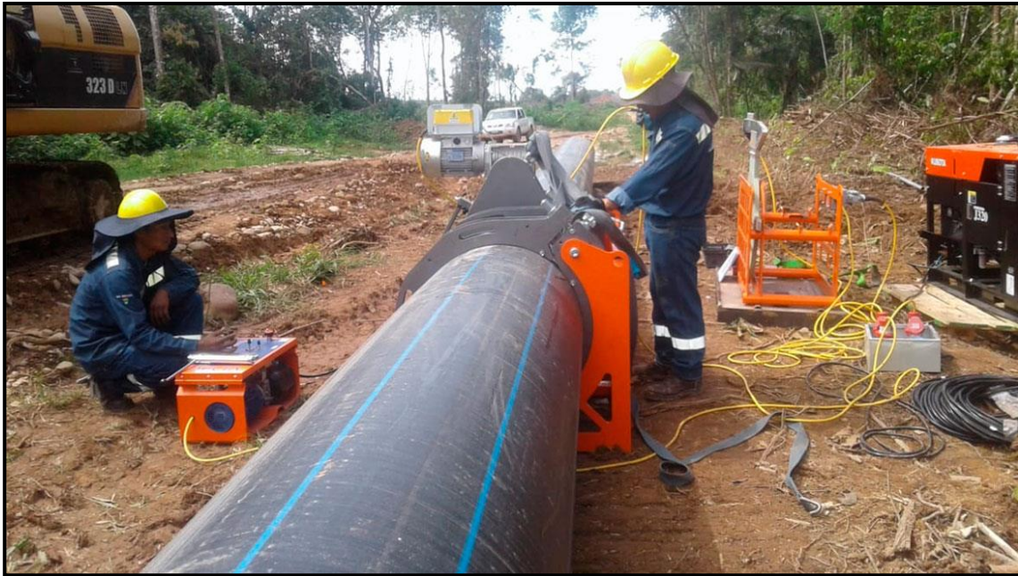
Figura 4: Termofusión de tuberías de gran envergadura FUENTE: https://www.plastiforte.com/ (2021).
