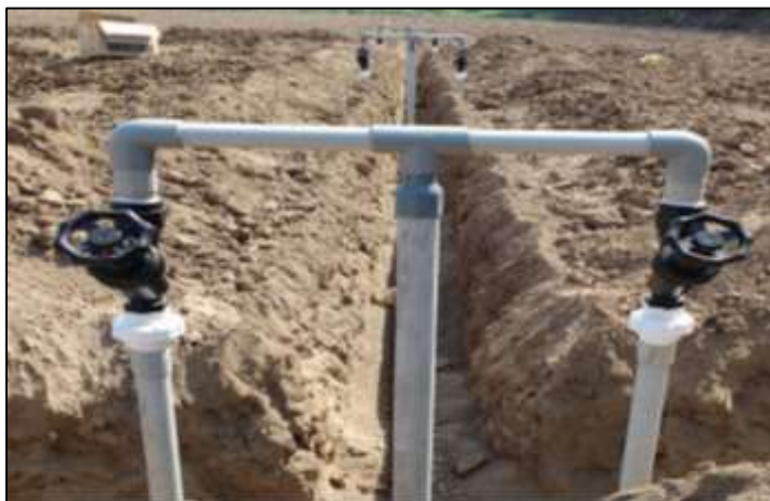
Colocación de los arcos de riego
