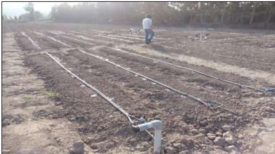
Figura 10: Instalación de una parcela de riego parcial
