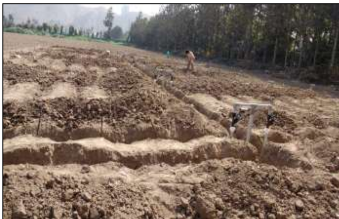
Colocación de tuberías
