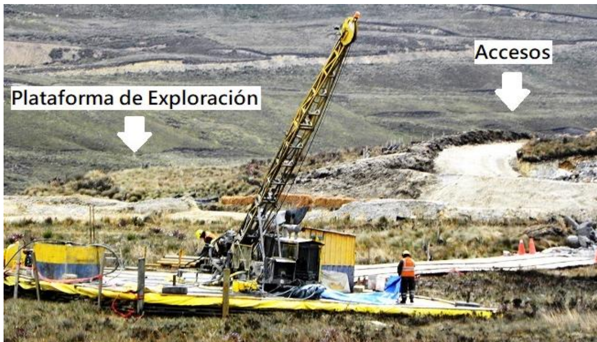
Figura 11: Plataforma de exploración con su respectivo acceso
