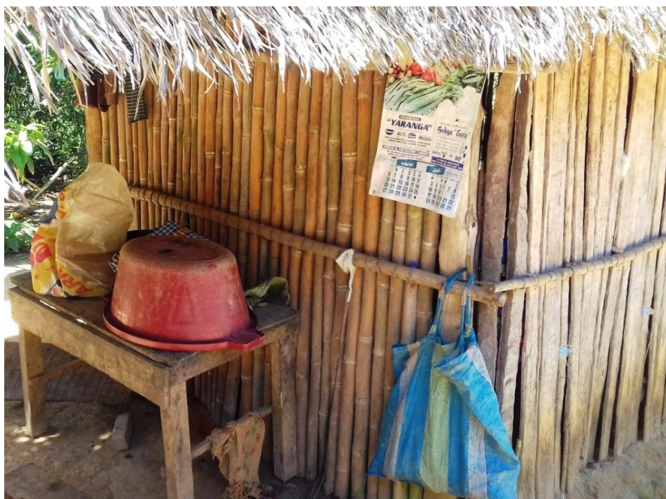
Figura 41: Vivienda elaborada con culmos de Guadua weberbaueri
