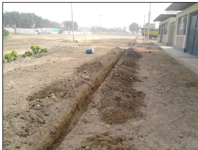
Figura 11: Excavación de zanjas para tubería matriz
