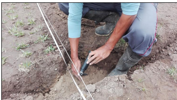
Figura 17: Instalación de difusores Rainbird serie 1800
