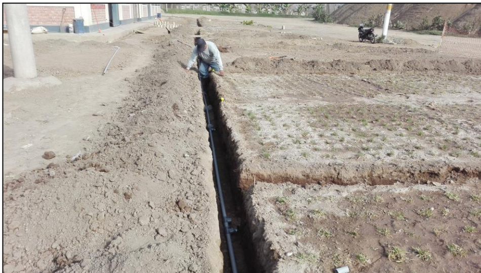
Figura 42: Instalación de tubería portalateral
