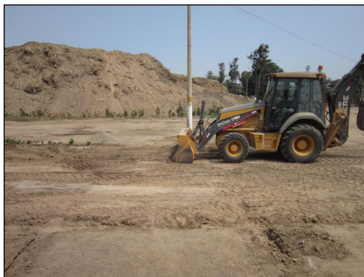
Figura 08: Nivelación del terreno con retroexcavadora
