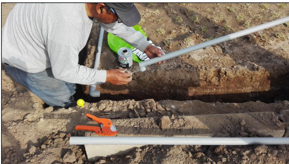
Figura 43: Instalación de tubería lateral
