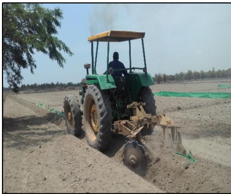
Figura 23. Construcción de bordos
