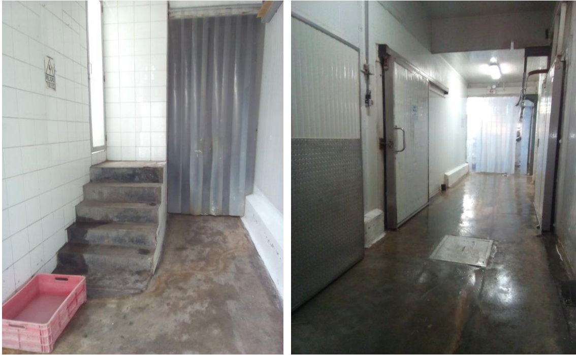
Figura 4: Izquierda: ingreso a Pasadizo 1. Derecha: Pasadizo 1 e ingreso a sala de desposte.
