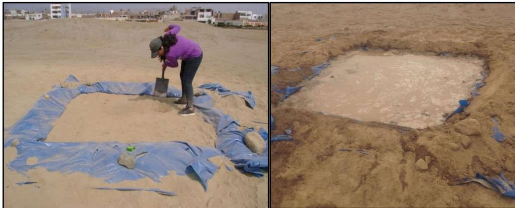
Figura 3.11: Construcción y llenado de las pozas de lavado (Poza-2 y Poza-3)
