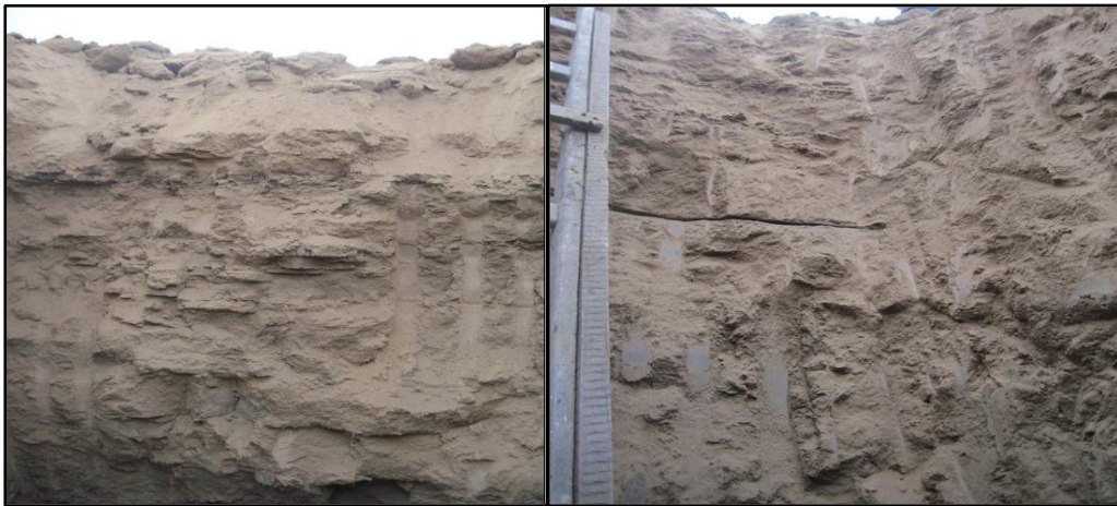
Figura 2.5: Vista del perfil de la calicata profunda CP1
