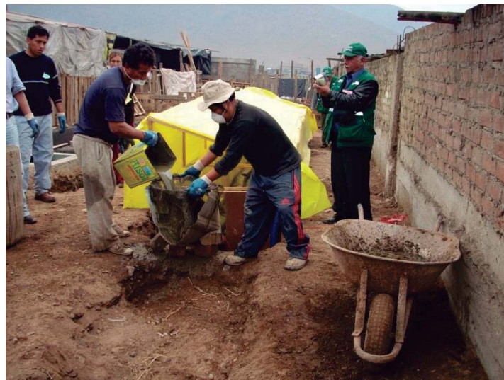
Foto 23 Llenado inicial de biodigestor
