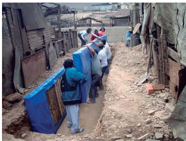
Foto 20 Instalación de cuna
