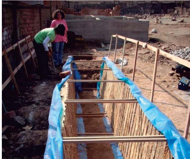
Foto 21 Instalación de columnas
