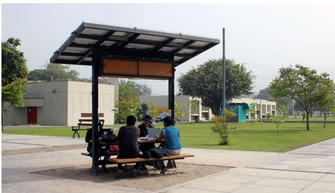
Figura 30: Módulos solares en el funcionamiento en el campus de la UNALM
