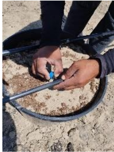
Figura 9. Instalación del sistema de riego por goteo, Izq: Puesta de manguera ciega de 16 mm, Cen: Perforación de la manguera para conectar el gotero insertable y Der: Campo experimental instalado con riego
