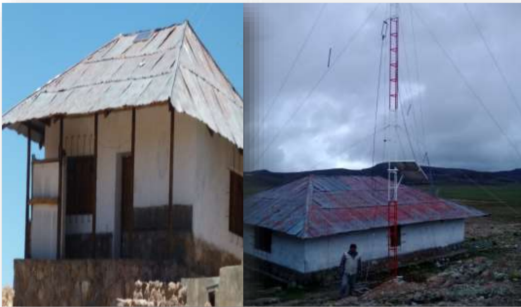
Figura 15. Garita de control y vigilancia e instalación de pararrayos en la C.C. de San Cristóbal
