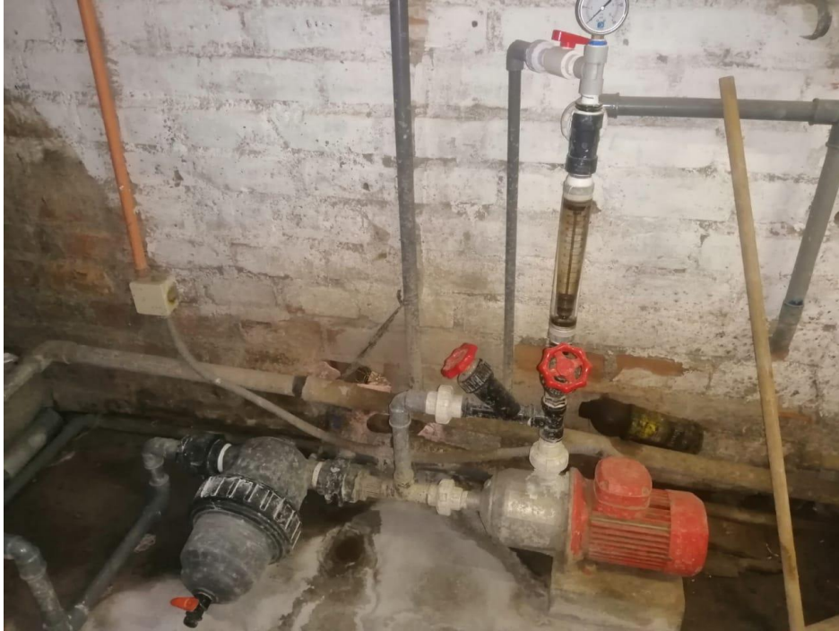
Figura 17. Bomba de fertilización, filtro y caudalímetro
