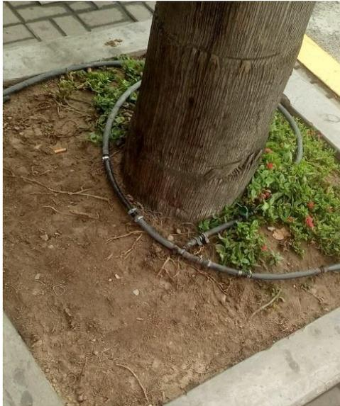
**Figura 7. Mal distribución de mangueras y goteros en jardineras del centro comercial en San Borja**
