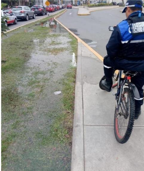
**Figura 5. Mal estado del sistema de riego por aspersión en el centro comercial de Jesús María**
