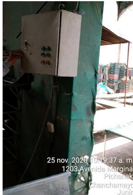
**Figura 17: Tablero Eléctrico en Planta de Proceso**
