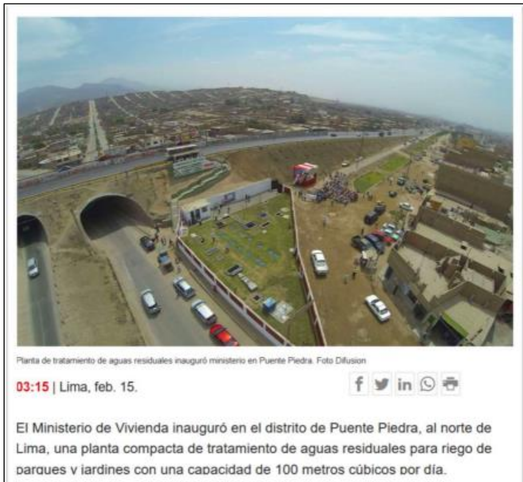
Figura 10: Planta de Tratamiento de Aguas Residuales de Puente piedra
