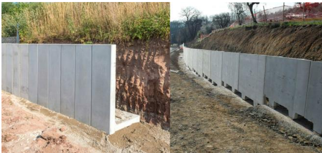
Figura 7: Muro de concreto
