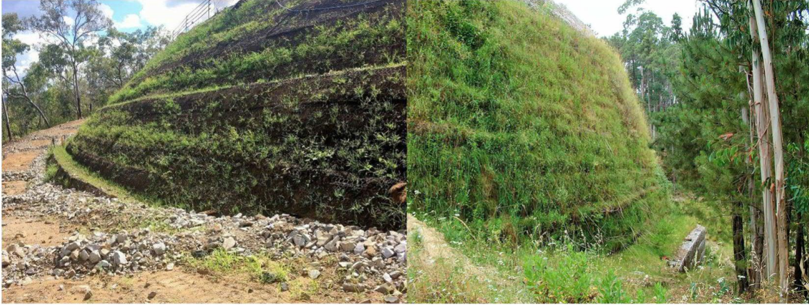
Figura 6: Muro de suelo reforzado – Terramesh
