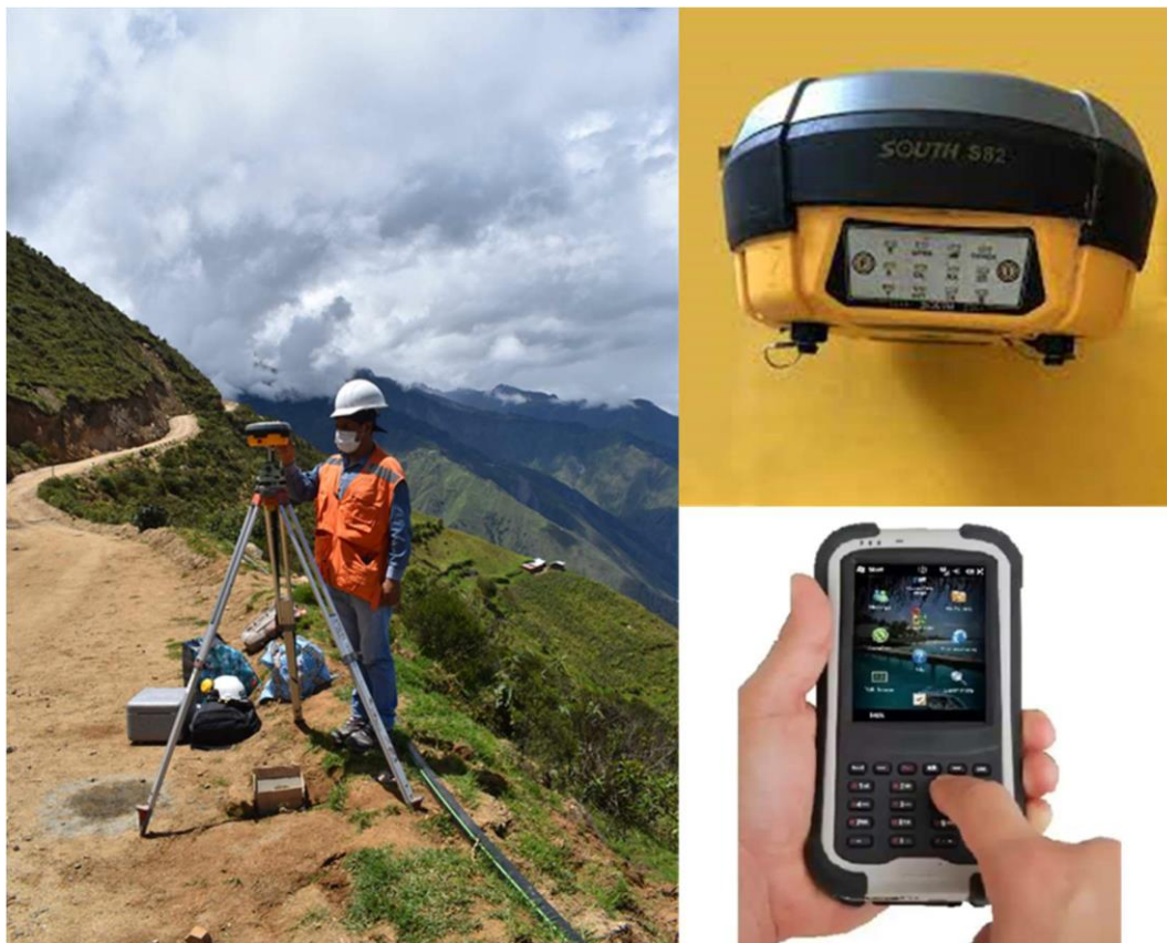
Figura 12: Equipos topográficos utilizados
