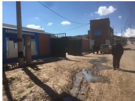
Residuo suero en exterior a la planta de Huata
