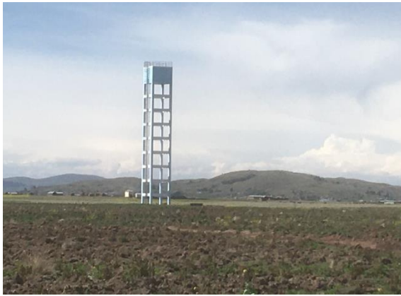
Tanques para agua en Caritamaya
