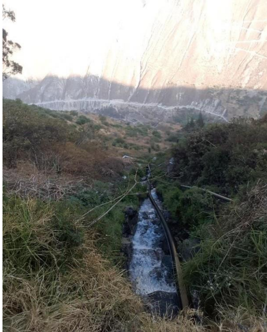
Tendido de Tubería de Polietileno HDPE 6" de alta densidad para conducción del recurso hídrico
