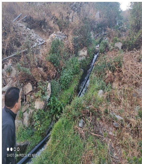
Tendido de Tubería de Polietileno HDPE 6" de alta densidad para conducción del recurso hídrico
