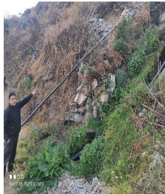
Tendido de Tubería de Polietileno HDPE 6" de alta densidad para conducción del recurso hídrico
