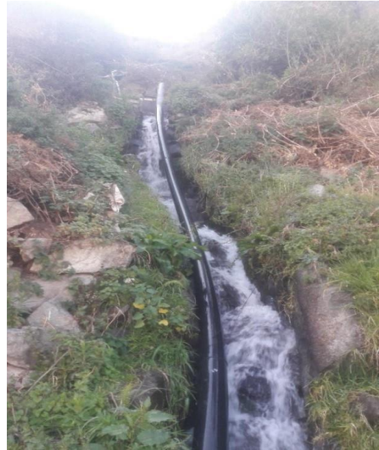
Tendido de Tubería de Polietileno HDPE 6" de alta densidad para conducción del recurso hídrico
