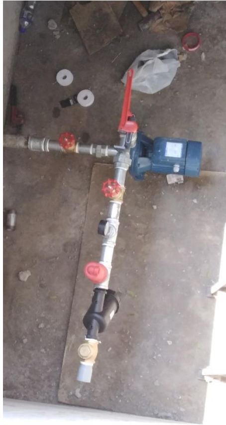
Figura 62: Instalación del cabezal
