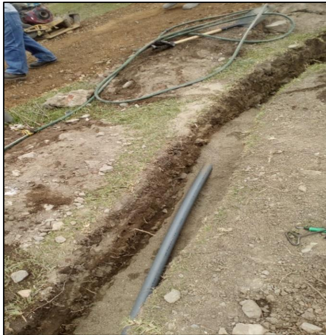
Figura 33: Relleno de zanja con material propio
