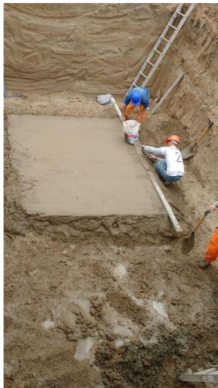
Figura 55: Vaciado de solado
