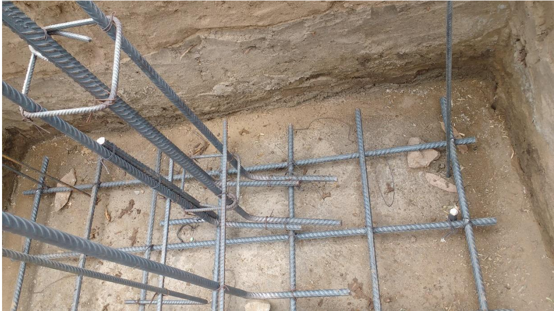
Figura 58: Habilitación de fierros de zapata para capilla
