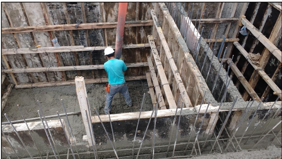
Figura 27: Vaciado de concreto pre mezclado
