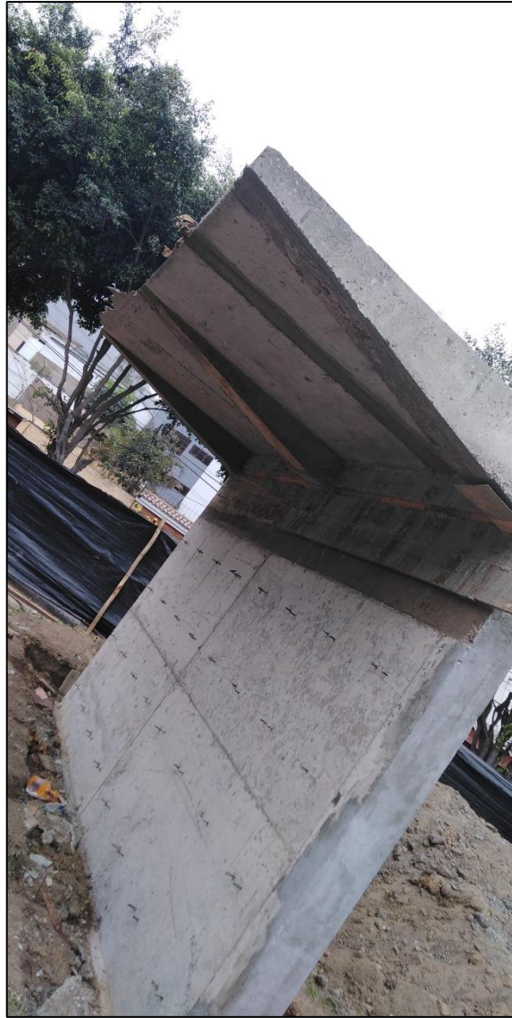
Figura 49: Desencofrado del muro de la Capilla
