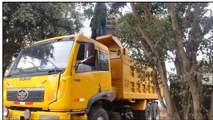
Figura 23: Eliminación de material excedente con volquete de 15 m 3
