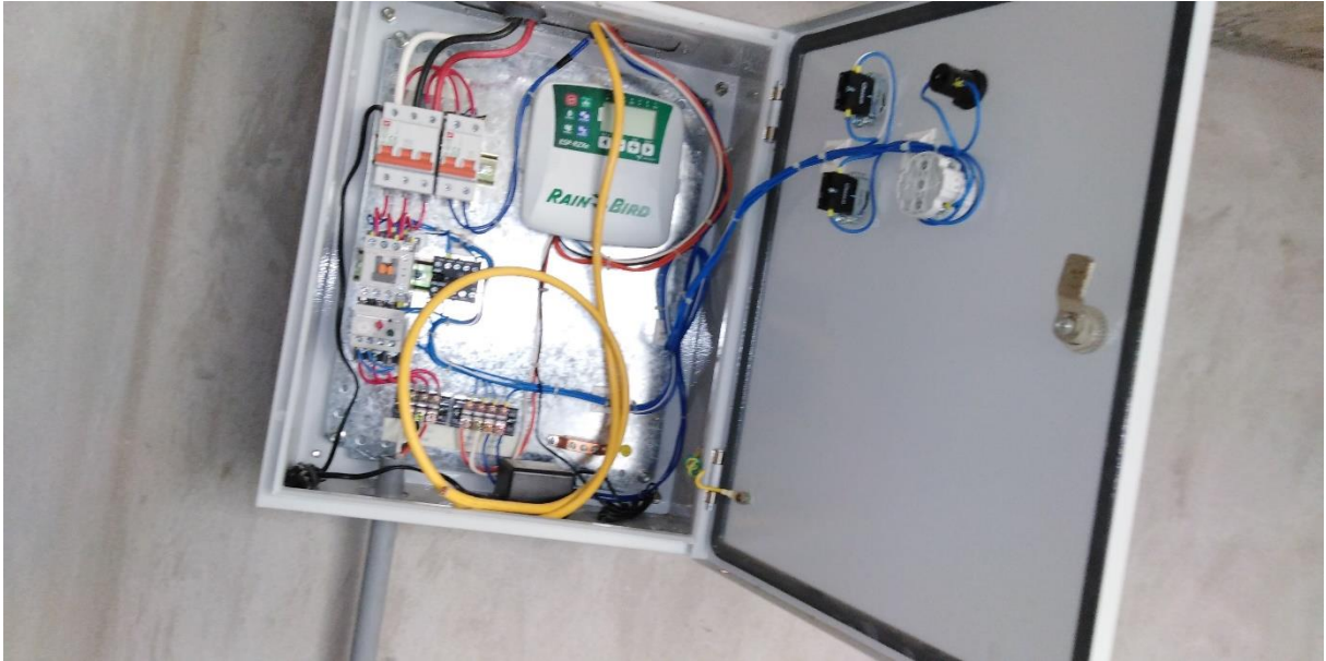
Figura 36: Instalación de tablero digital del sistema de riego
