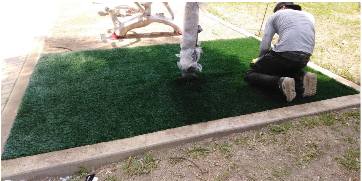
Figura 63: Colocación de grass sintético
