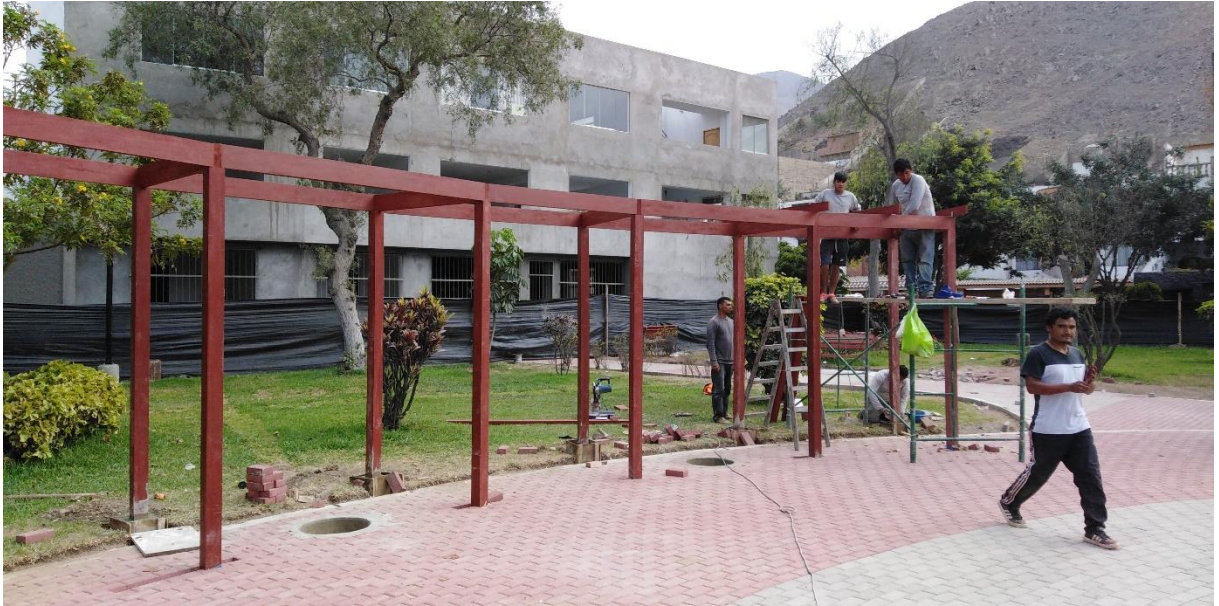
Figura 64: Construcción de pérgola
