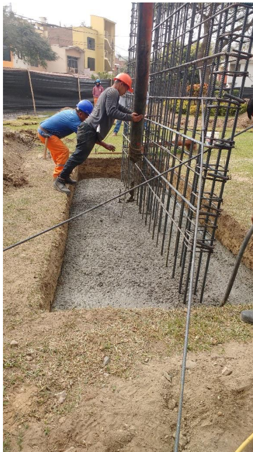
Figura 59: Habilitación de fierros de muro para capilla
