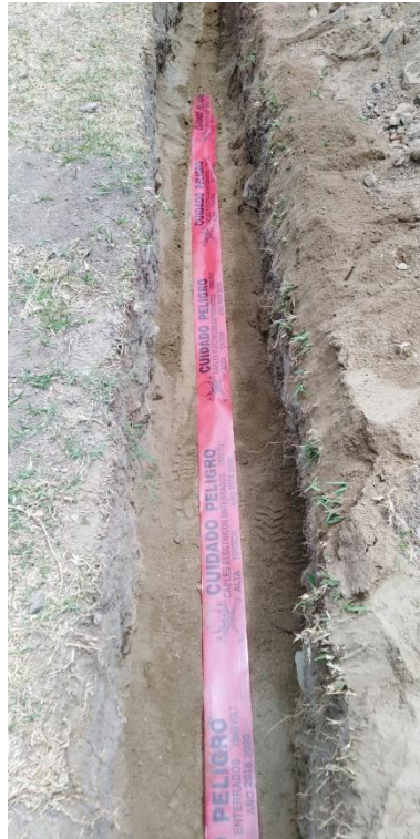
Figura 38: Tapado de zanja de cable eléctricos con señalización
