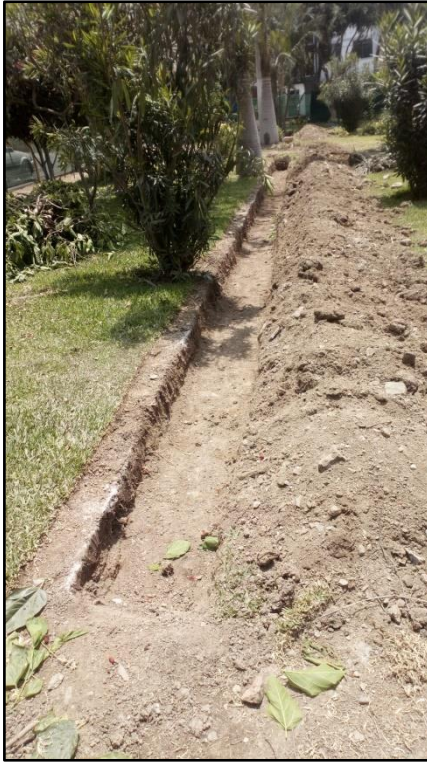
Figura 30: Excavación de zanja para tendido de tubería del sistema
