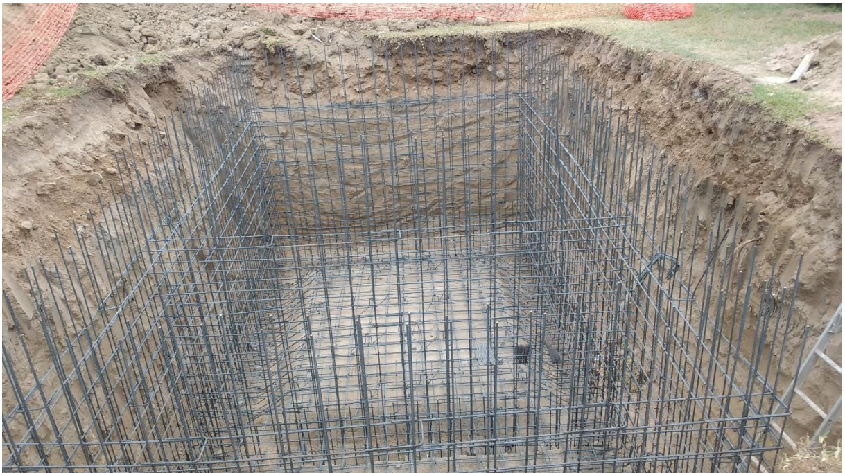
Figura 57: Habilitación de fierros para la cisterna
