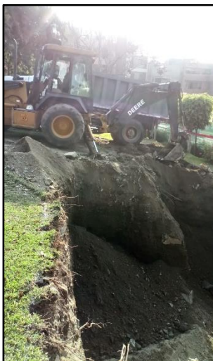
Figura 22: Excavación de zanja con retroexcavadora
