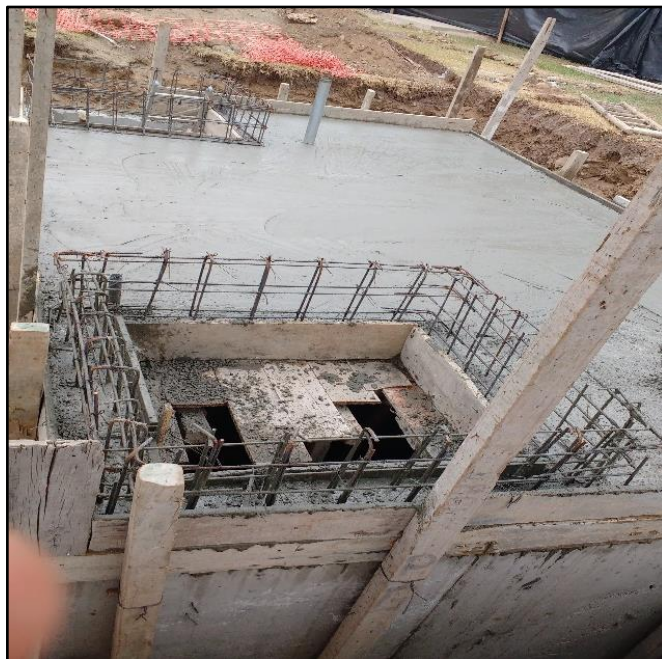
Figura 29: Vaciado de concreto techo de cisterna y cuarto de bomba
