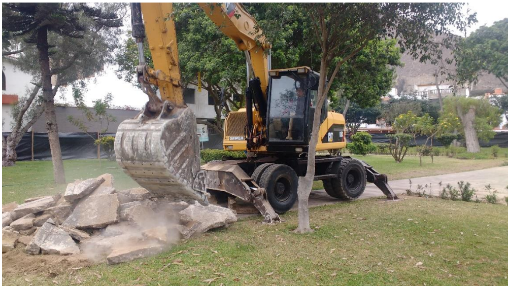
Figura 42: Demolición de veredas
