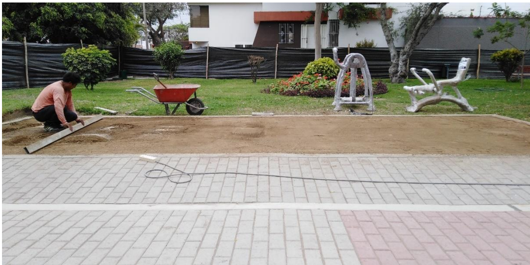
Figura 40: Preparación de terreno para Bio Gimnasio
