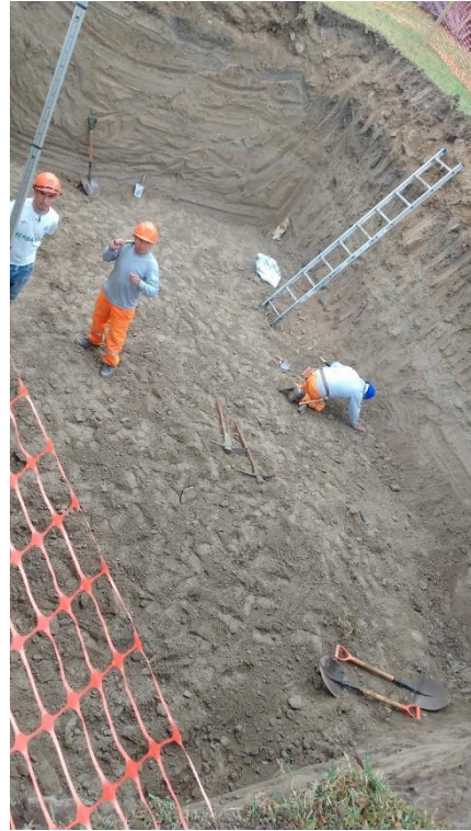
Figura 54: Excavación de terreno
