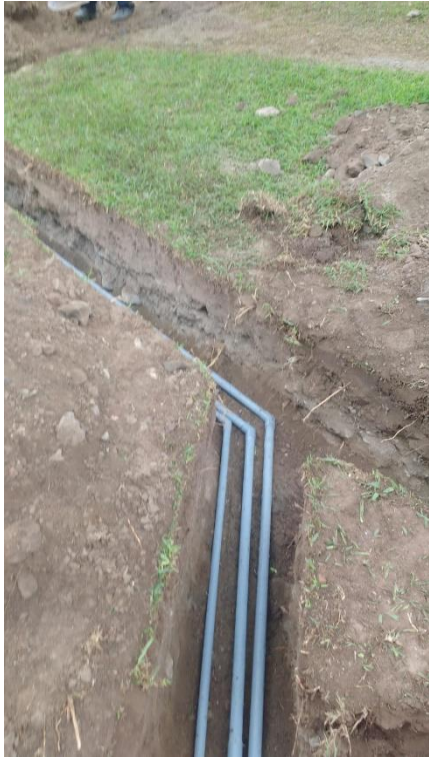
Figura 53: Instalación de tuberías de riego
