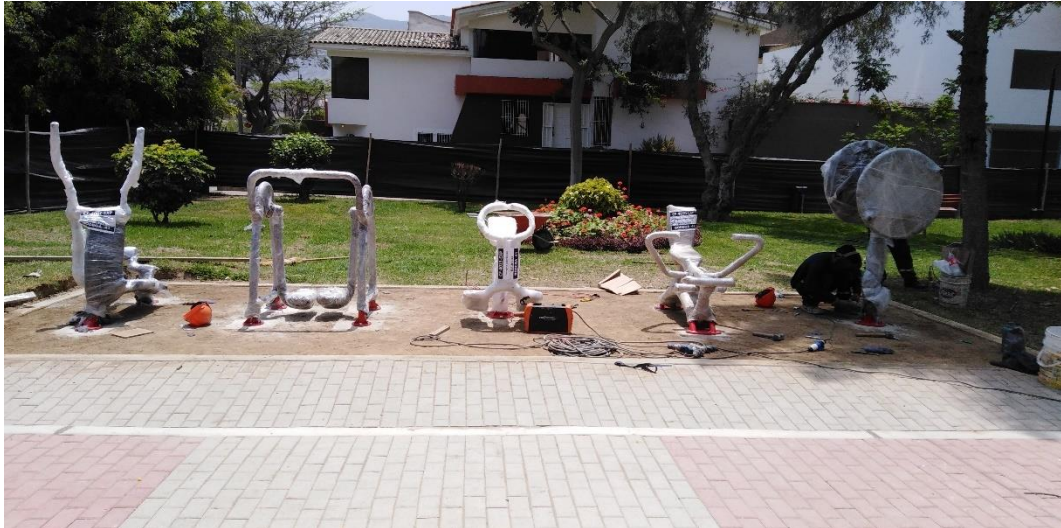
Figura 41: Instalación de Bio Gimnasio
