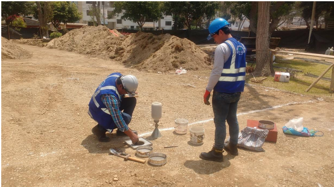
Figura 52: Prueba de Compactación de subrasante de Plazuela
