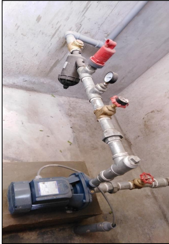
Figura 35: Cabezal de riego
