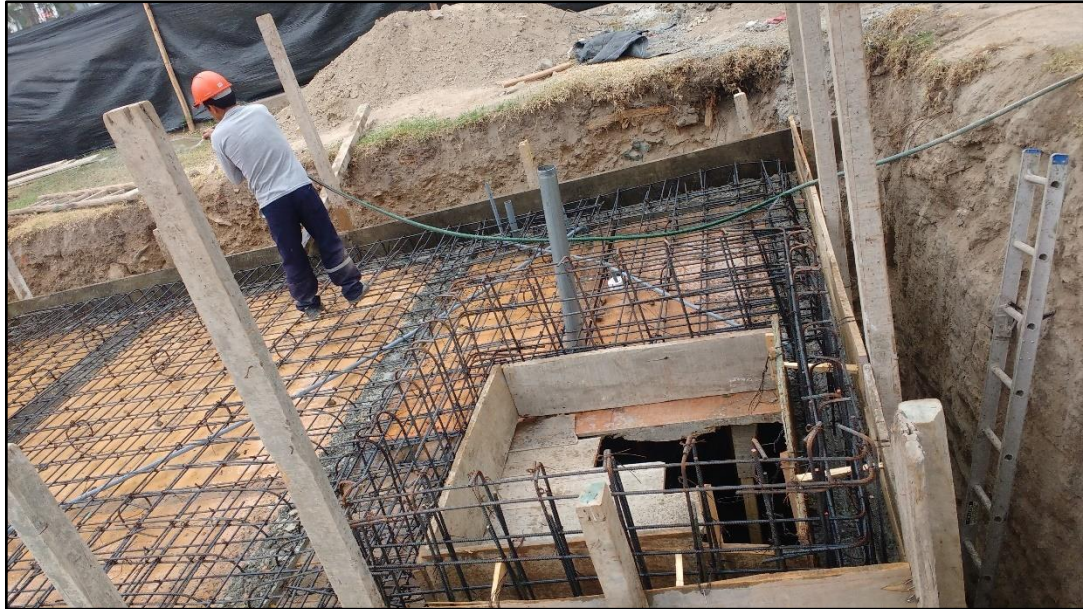
Figura 28: Encofrado y malla de fierro de techo de cisterna y cuarto de bomba
