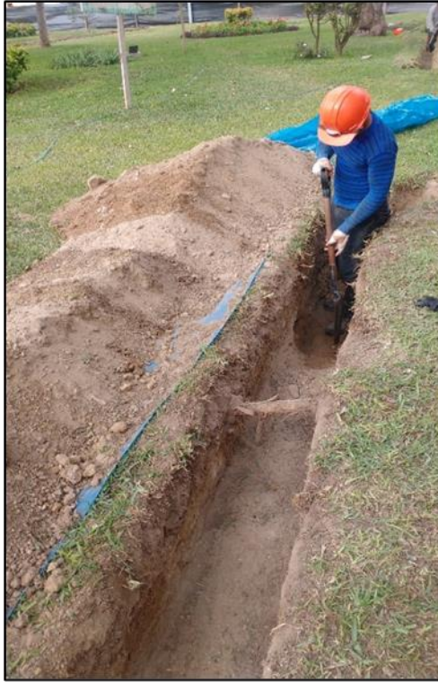
Figura 37: Excavación de zanja para cableado eléctrico
