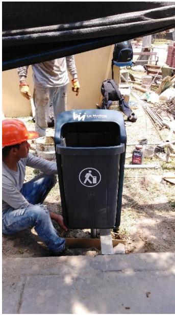
Figura 46: Instalación de tacho de basura
