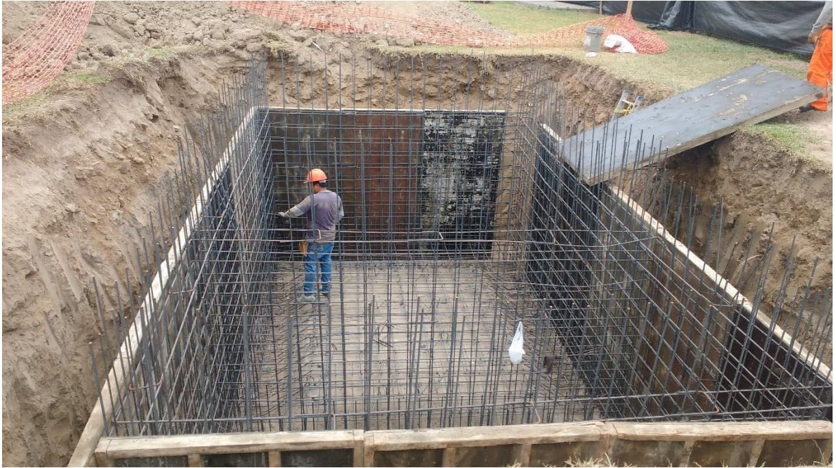
Figura 56: Habilitación de fierros para la cisterna
