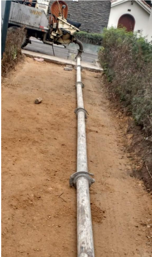
Figura 60: Llenado de concreto premezclado
