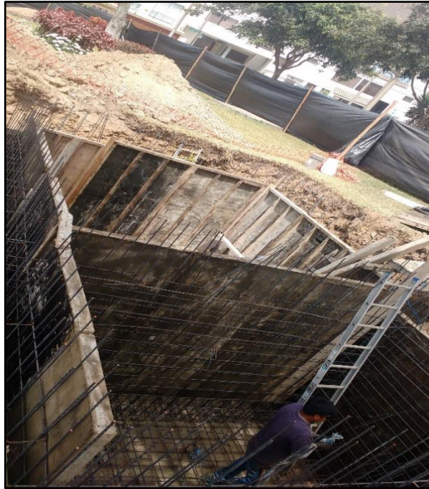
Figura 26: Encofrado con paneles
