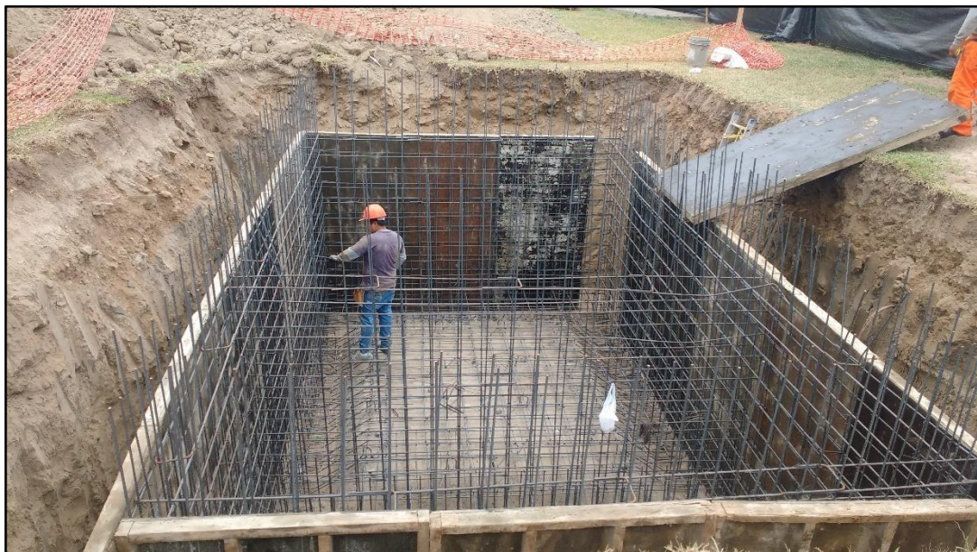
Figura 25: Construcción (habilitación) de mallas de fierro
