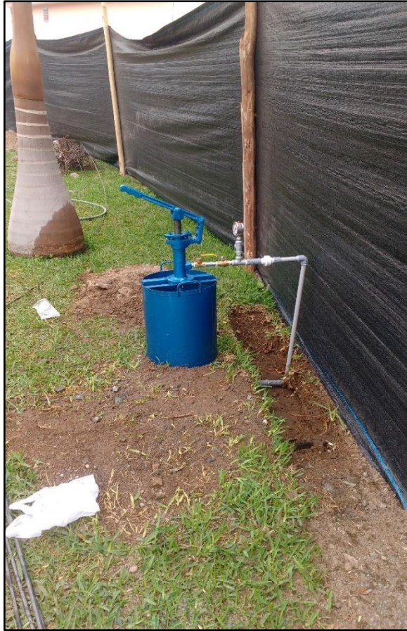
Figura 32: Prueba hidráulica
