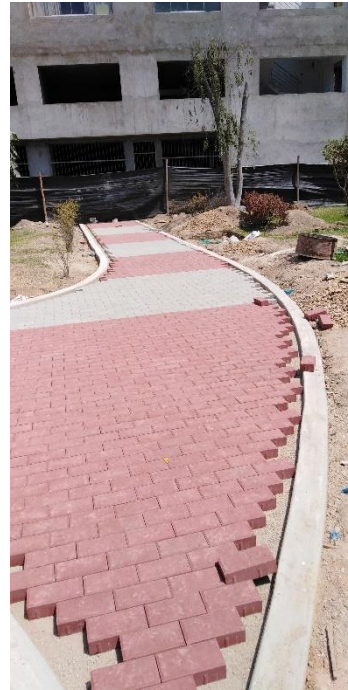
Figura 44: Instalación de Adoquines
