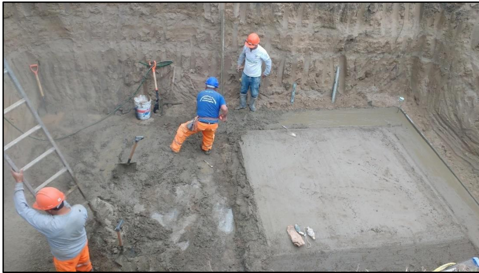
Figura 24: Vaciado de solado en cisterna y cuarto de bomba
