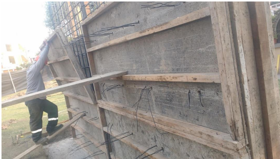
Figura 48: Encofrado del muro de la Capilla
