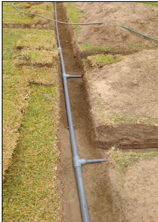
Figura 31: Suministro e instalación de tubería del sistema de riego
