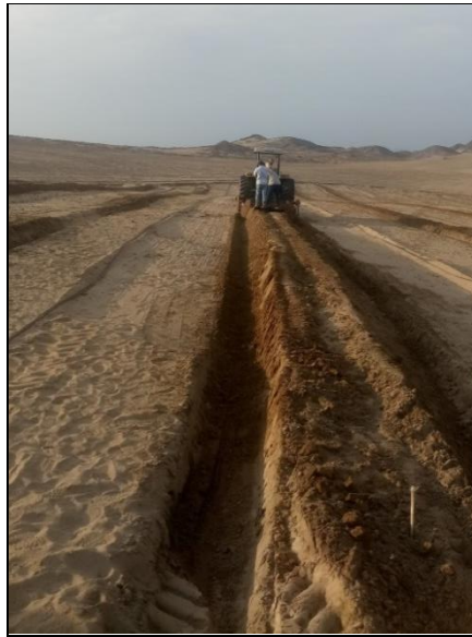
Figura 5: Camellón completado con sus dimensiones finales
