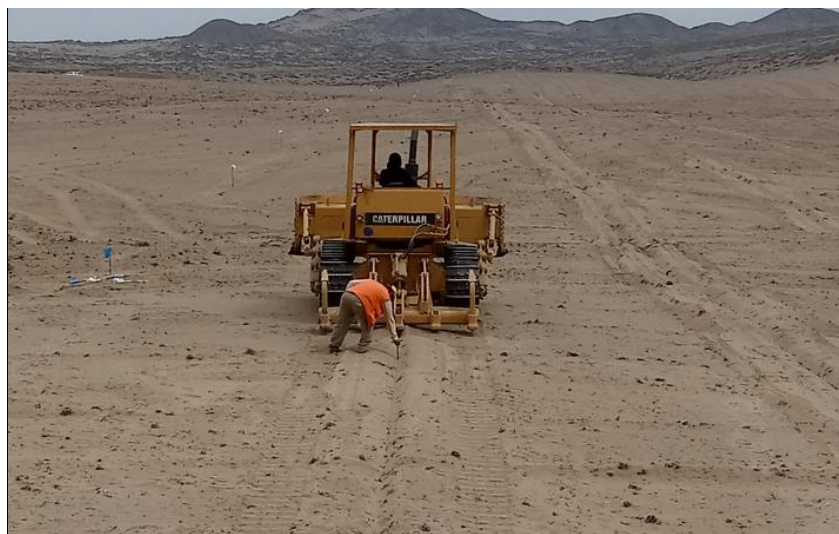
Figura 3: Proceso de subsolado
