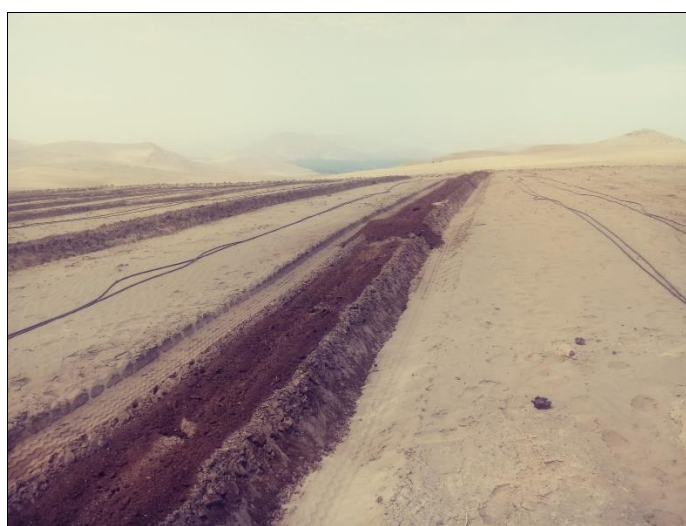
Figura 4: Pre-camellón formado y mezclado con la materia orgánica
