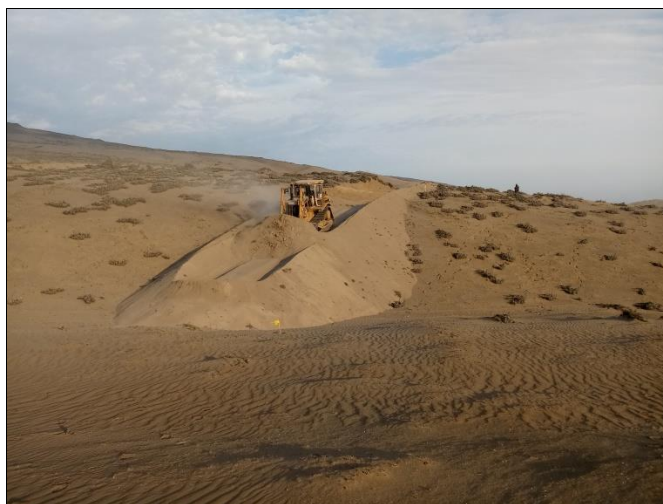
Figura 2: Nivelación del campo
