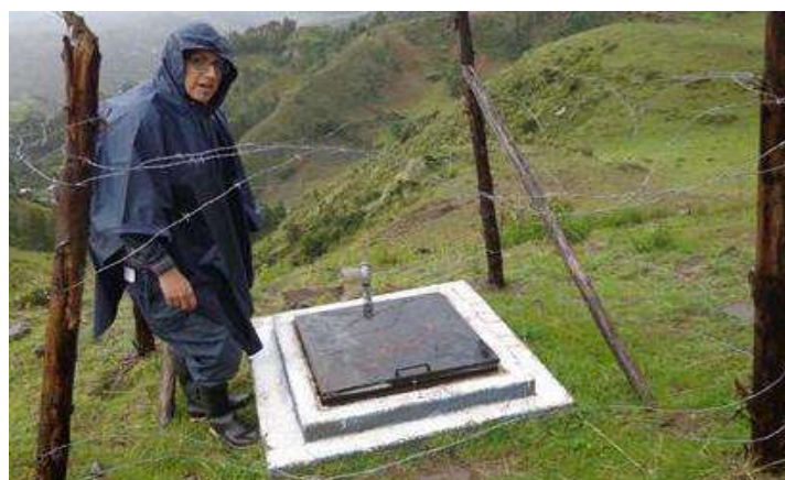
Figura 16: CRP T-VI N°02
