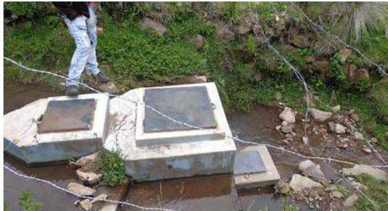
Figura 11: Estructura de la captación “Sorana”
