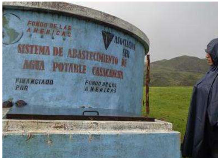
Figura 20: Tapas del reservorio “Sorana”
