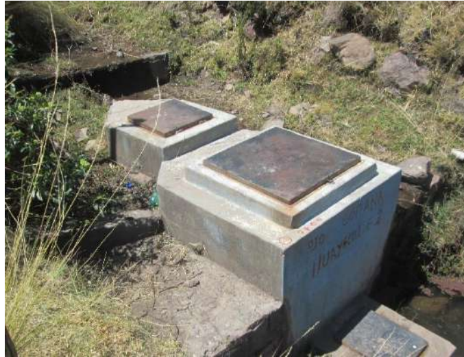
Figura 10: Fuente de abastecimiento
