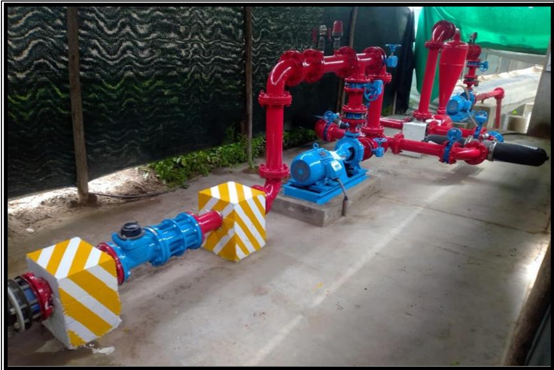
Figura 16: Manifold de riego de la urbanización San Antonio de Mala
