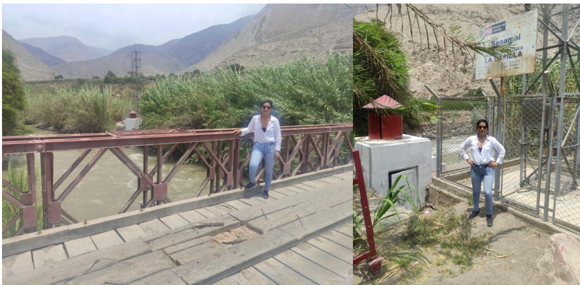
Figura 57: Registro Fotográfico – Estación La Capilla
