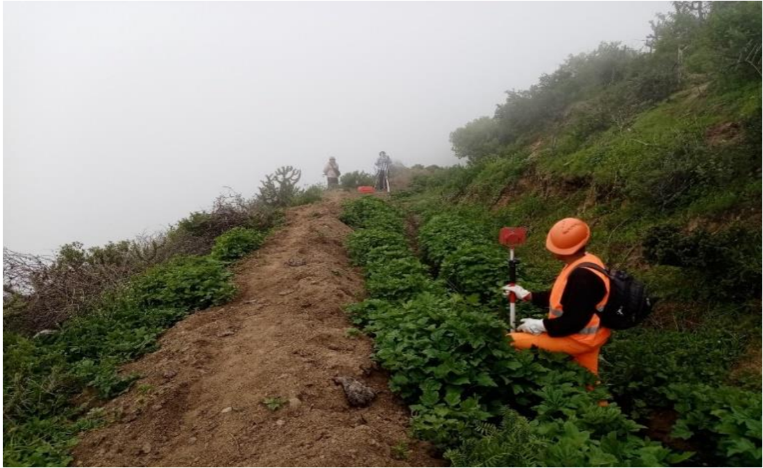
Figura 11: Levantamiento topográfico del canal amunero
