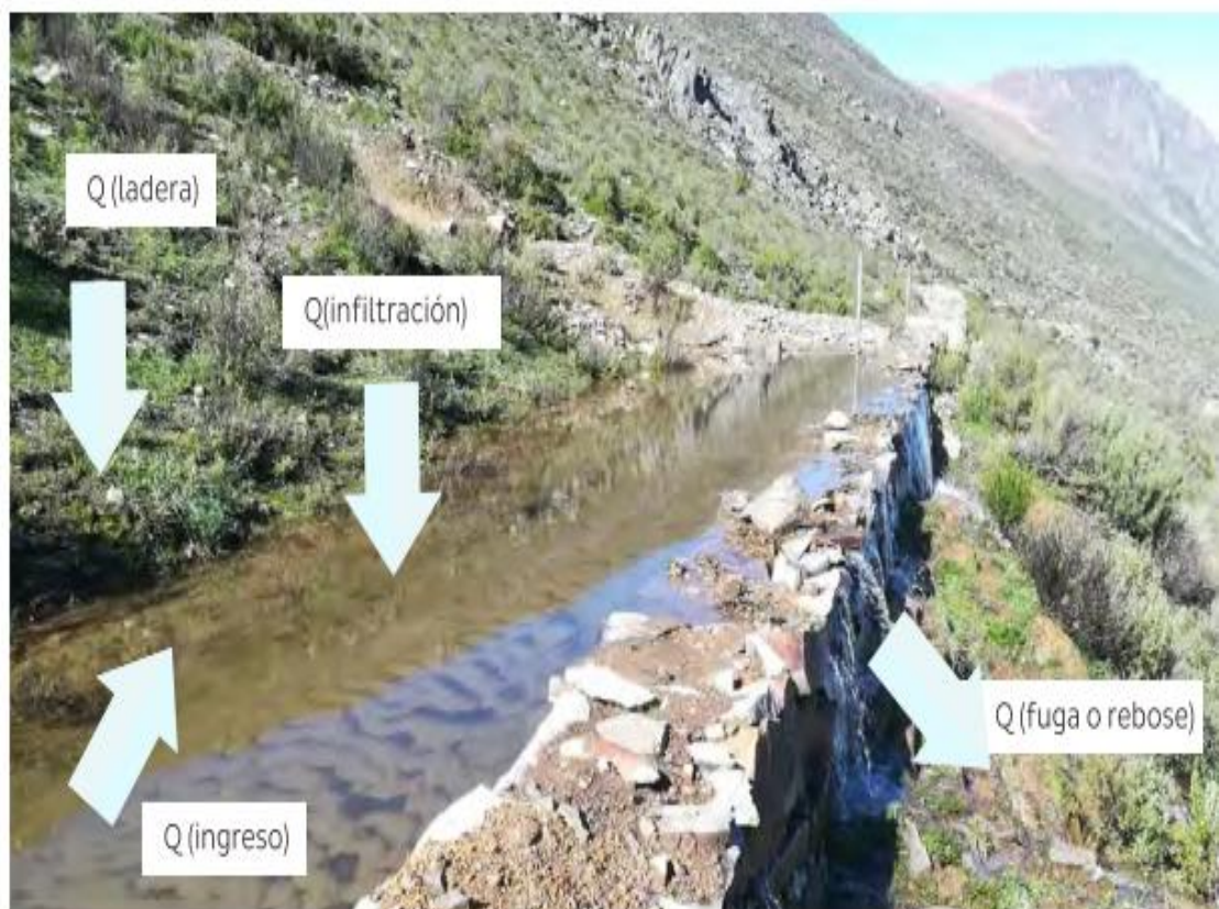
Figura 21: Esquema caudales de ingreso, infiltración, fuga y aporte de ladera
