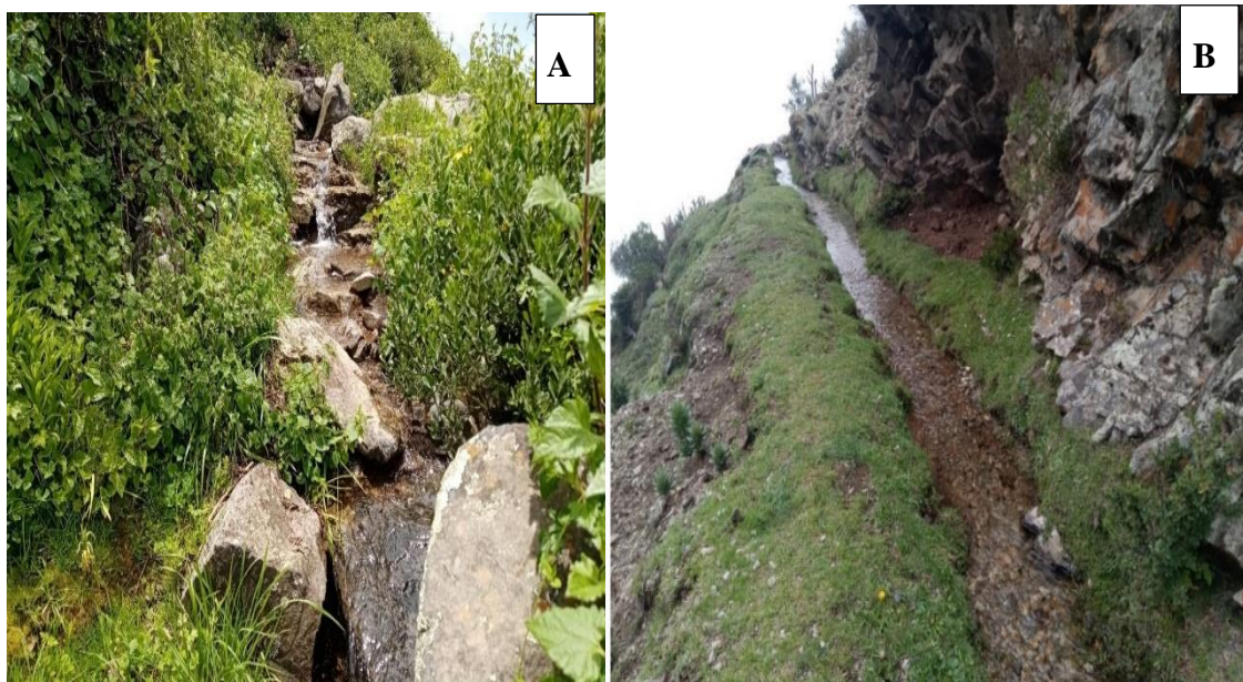
Figura 9: Tramo del canal amunero: (A) rocas alineadas donde pasa el agua; y, (B) existencia de canales de agua
