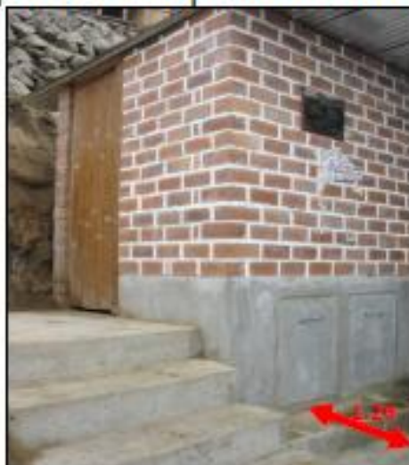
Figura 3. Separación de las compuertas para el mantenimiento
