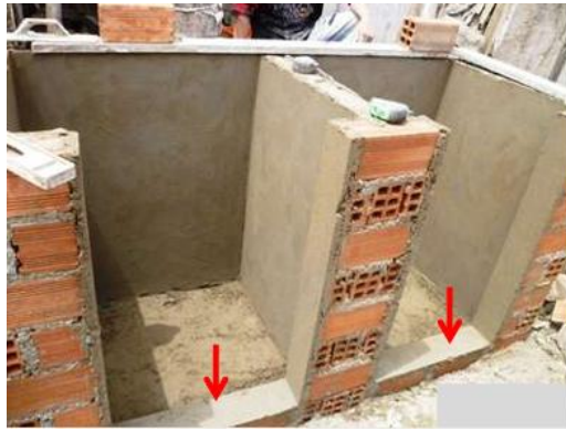
Figura 22: Bordos de la compuerta
