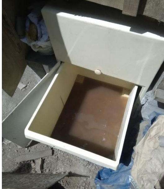
Figura 32: Familia usuaria reporta que el contenedor de estabilización se encontraba con agua
