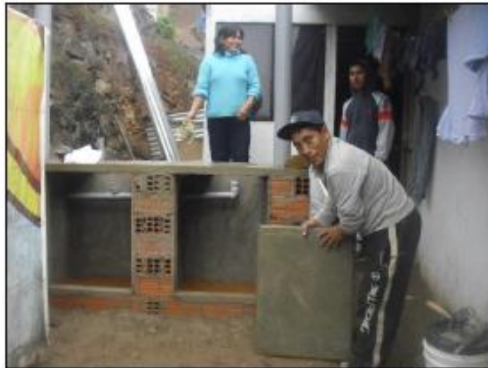
Figura 12. Colocación de las compuertas en las cámaras.
