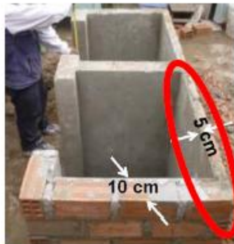
Figura 6. Detalles de las cámaras de deshidratación.
