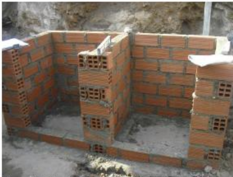
Figura 5. Sentado de las 7 hileras de ladrillo.
