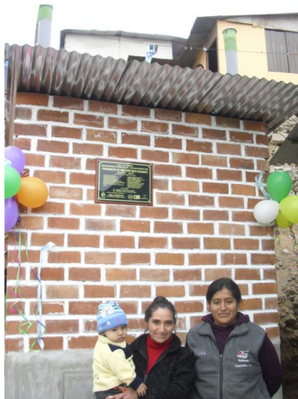
Figura 7: Cuarto de baño seco con paredes de ladrillo y techo de calamina
