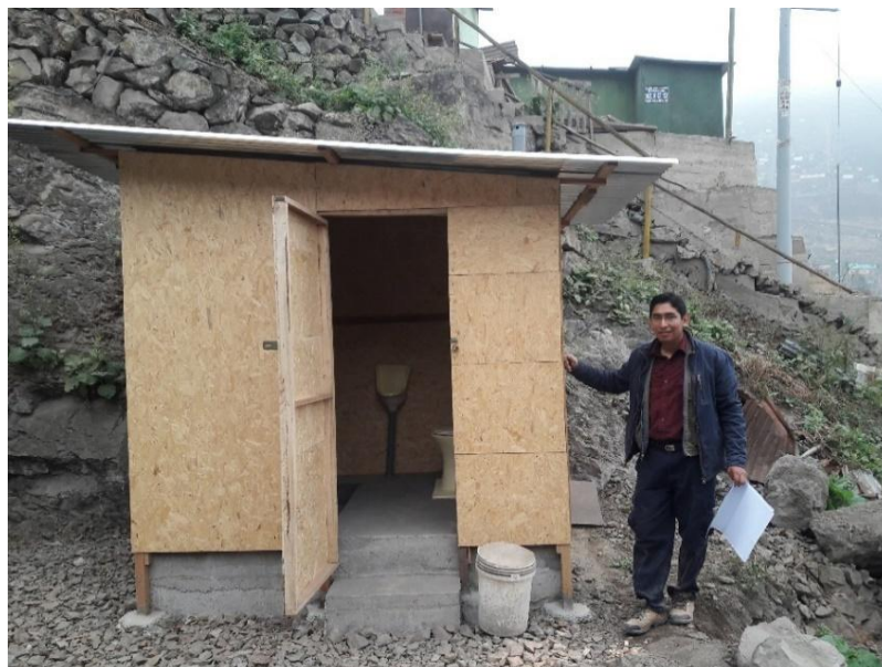
Figura 30: Baño seco modelo DryMix Culinado
