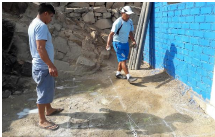
Figura 26: Visita técnica para la ubicación del baño y de la zona de infiltración de aguas grises
