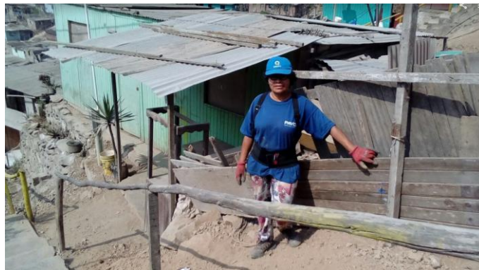
Figura 17: Vivienda con paredes de machihembrado
