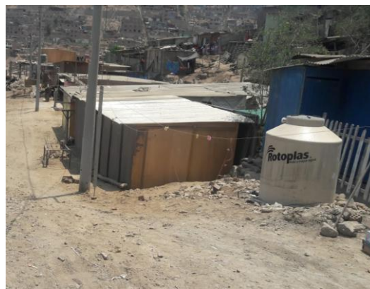
Figura 18: Vivienda con techo de calamina
