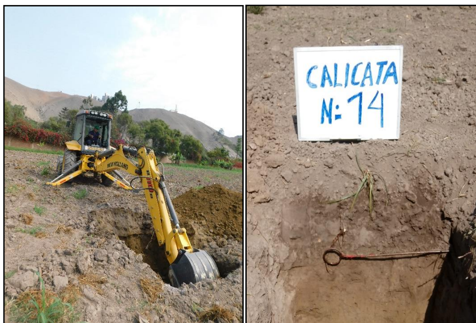
Figura 11: Calicata hecho con máquina retroexcavadora y calicata hecha a mano
