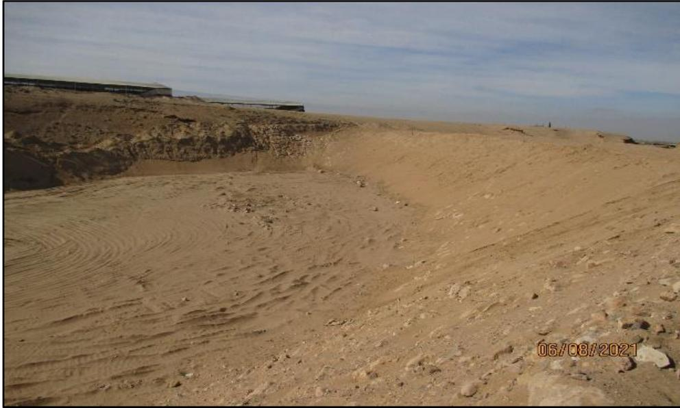
**Figura 44: Dique construido en la Quebrada del Diablo cerca de la ciudad de Tacna. Muestra un ancho aproximado de 60.0 m. (0367165 O, 8015109 N)**
