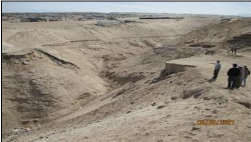
**Figura 14: Lugar del dique colapsado por la crecida del 21 de febrero del 2020 y que provocó el aluvión ocurrido en la ciudad de Tacna**
