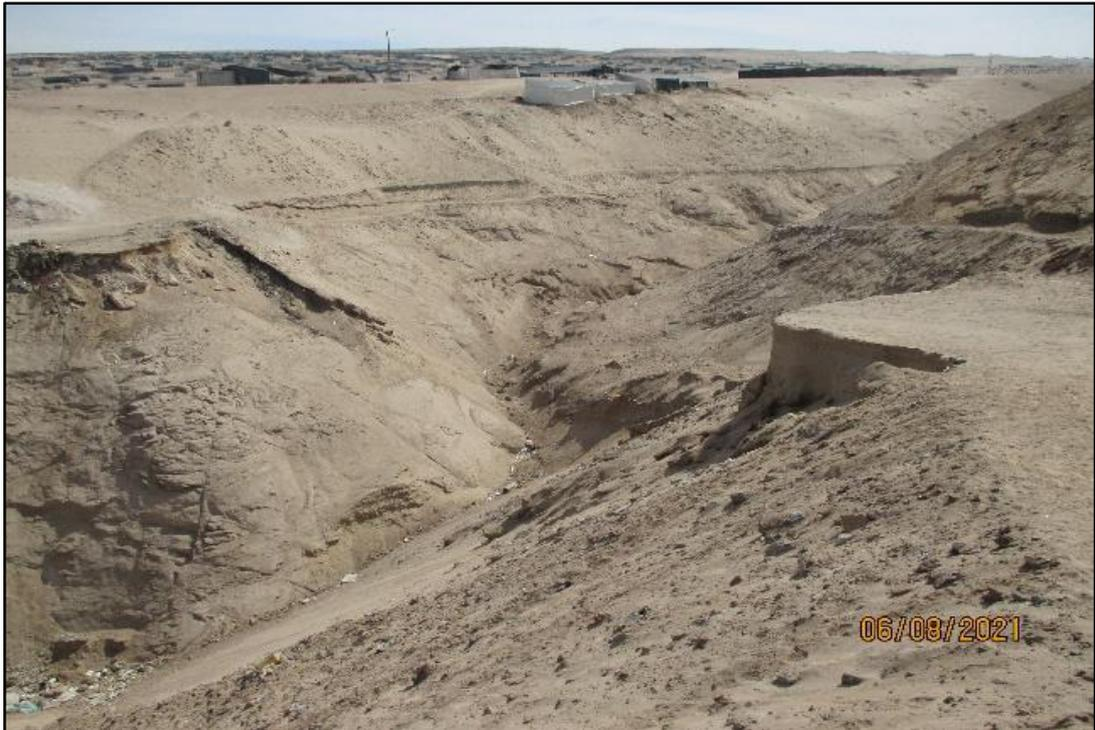
**Figura 48: Lugar del dique colapsado por la crecida del 22/FEBRERO/2020 y que provocó el aluvión hacia la ciudad de Tacna. Punto ubicado a 2.0 km del centro poblado La Florida. (0366535 O, 8011502 N)**
