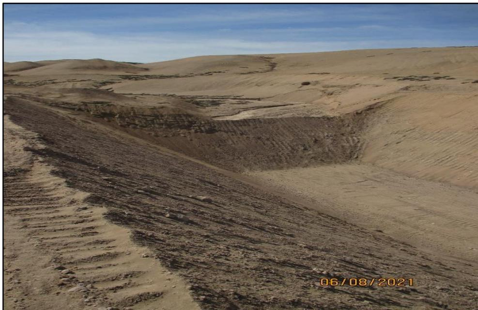
**Figura 45: Excavación y construcción del dique construidos a inicios del mes de junio del 2021 en la parte media de la Quebrada del Diablo (0368216 O, 8018930 N)**
